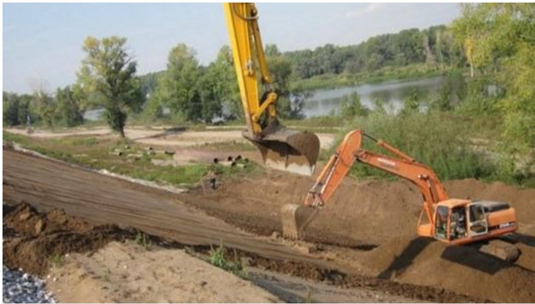
Рис. 5.8. Окончательная планировка откосов насыпи экскаваторами
