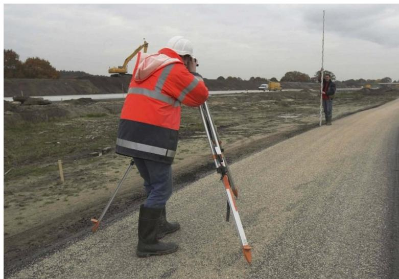
Рис. 5.6. Нивелирование земляного полотна
