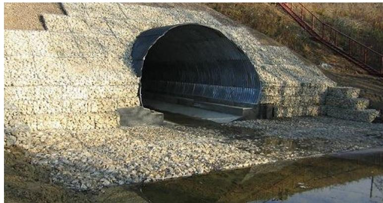
Рис. 5.5. Укрепление откосов у выходного оголовка арочной гофрированной водопропускной трубы
