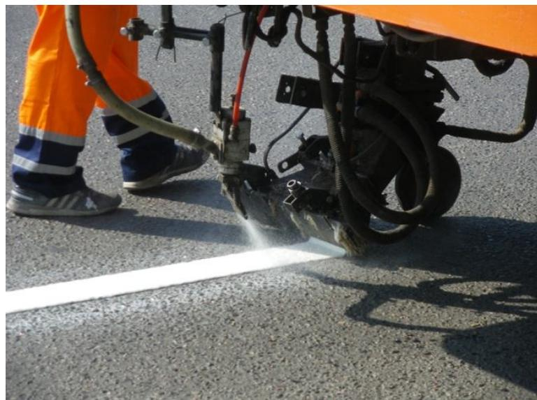
Рис. 5.17. Нанесение разметки на проезжую часть
