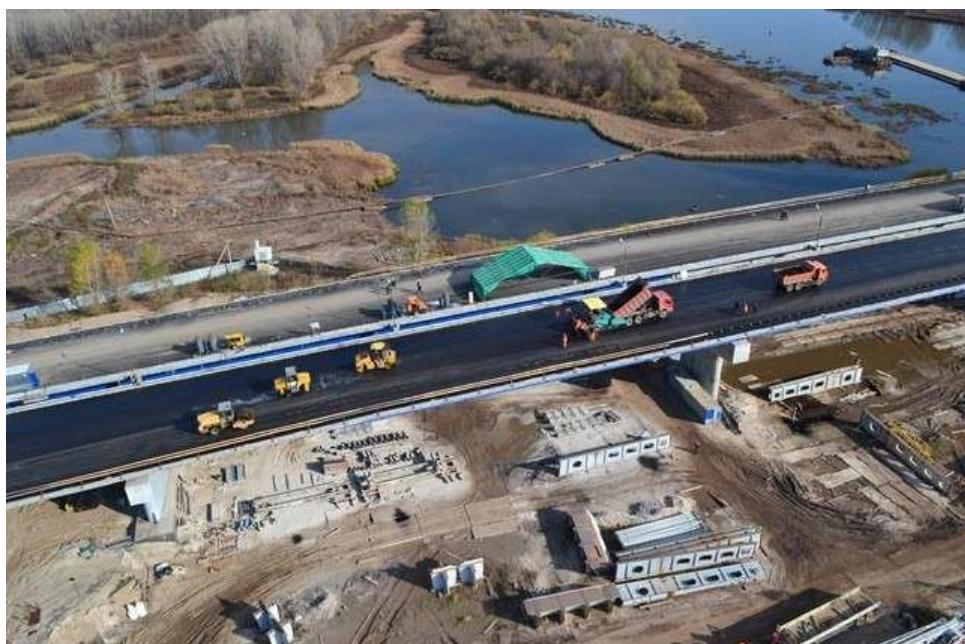
**Рис. 7.1. Строительство асфальтобетонного покрытия автомобильной дороги**
