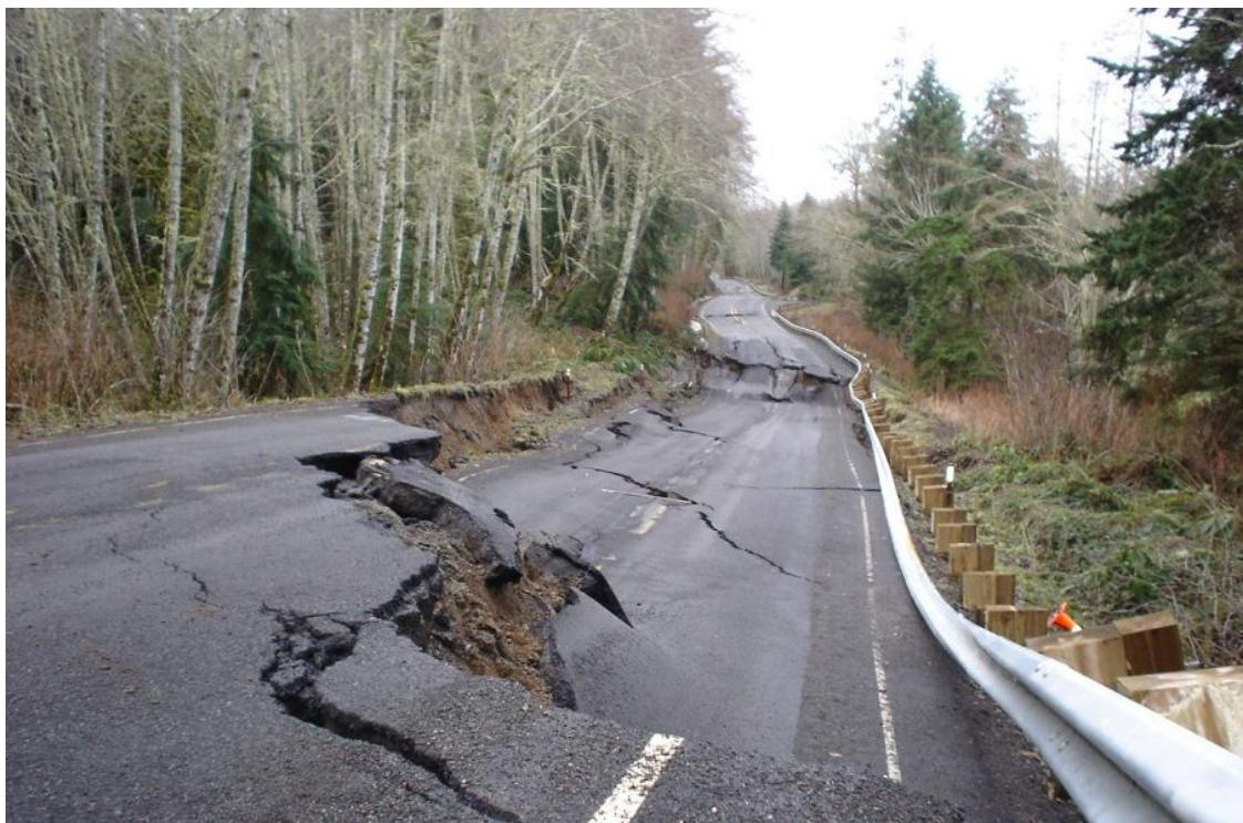
Рис. 5.19. Участок дороги, разрушенный оползнем
