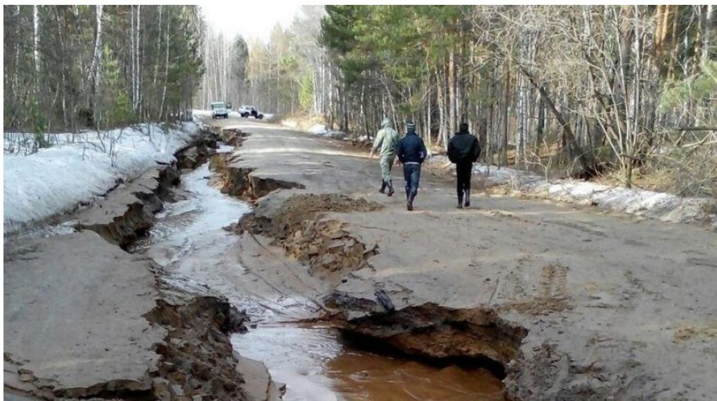
Рис. 5.38. Разрушение дорожной конструкции в Омской области паводком
