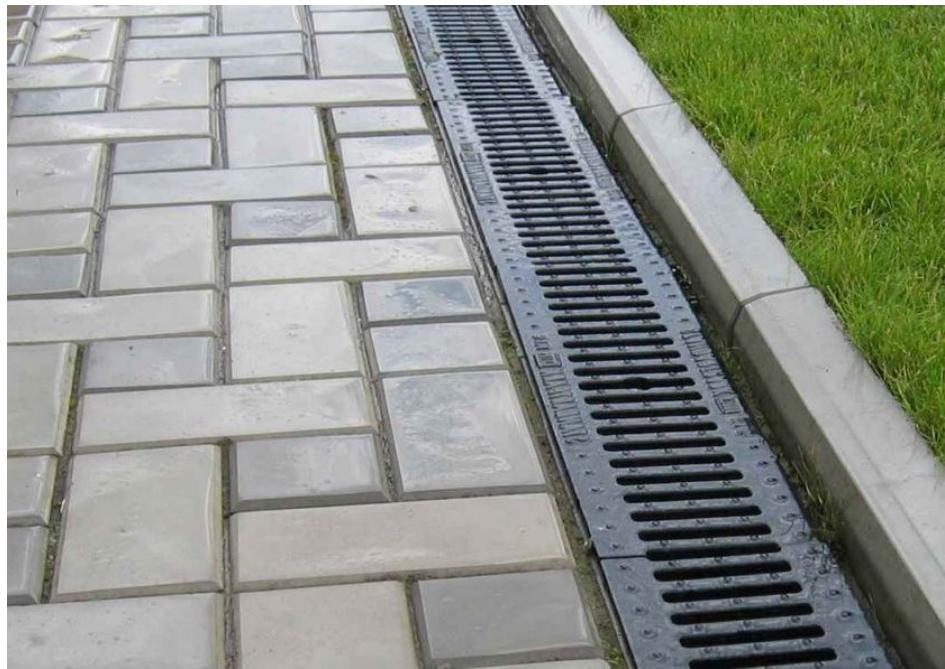
Рис. 5.20. Переустройство ливневой канализации на тротуаре
