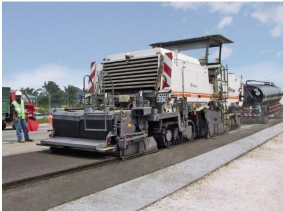
Рис. 5.21. Укладка слоя покрытия методом «холодного ресайклинга»
