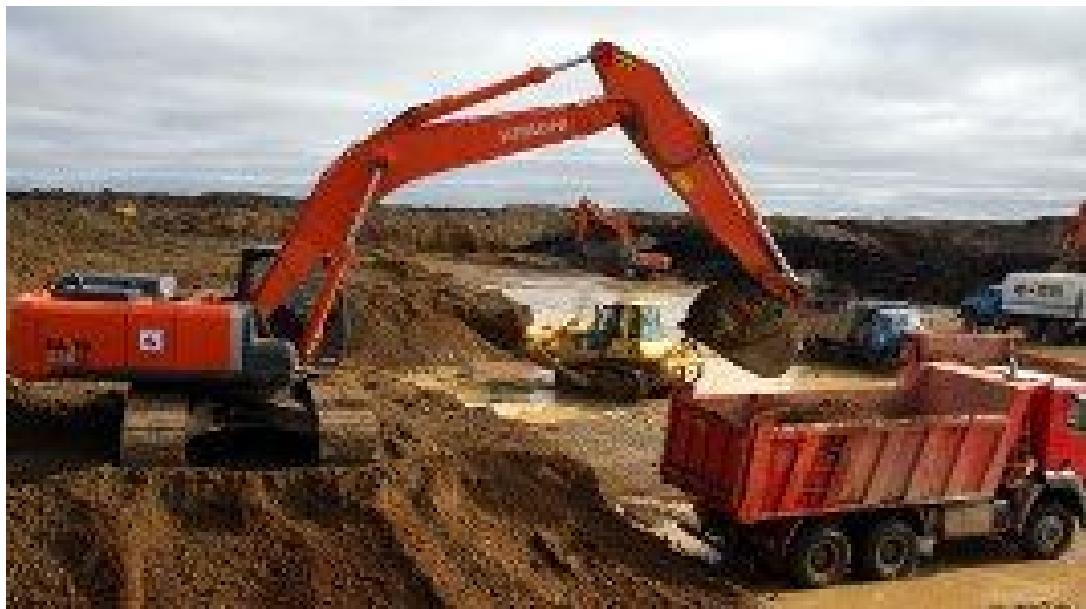
Рис. 5.9. Разработка грунта в карьере экскаватором
