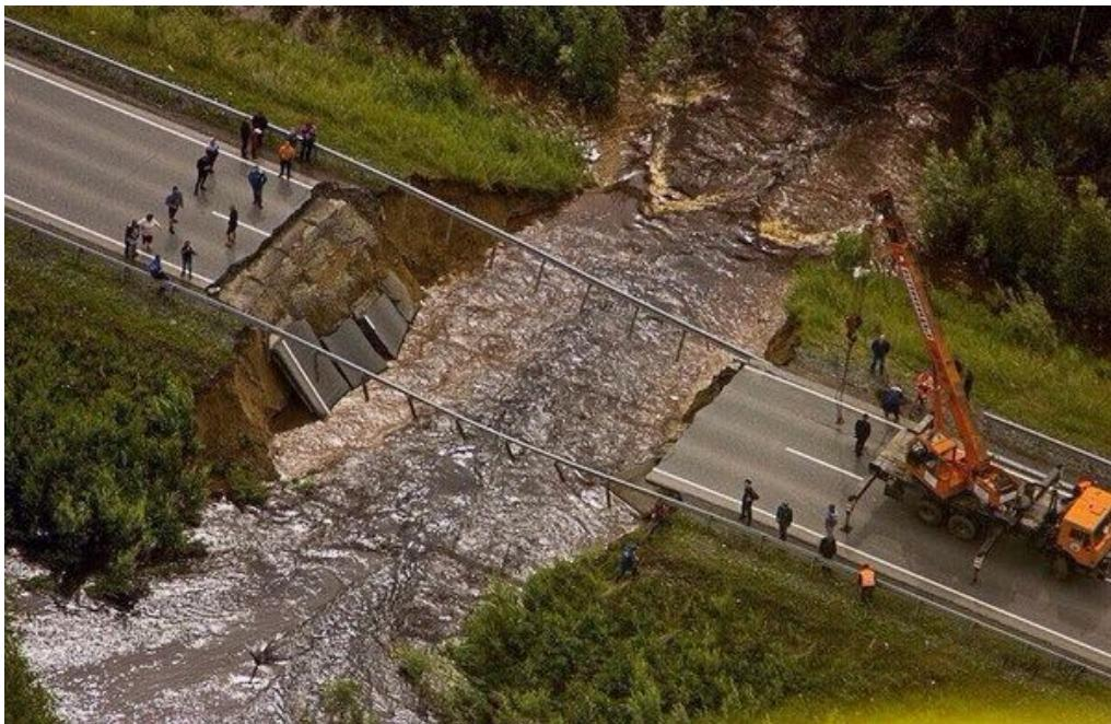
Рис. 5.24. Размытый участок автомобильной дороги
