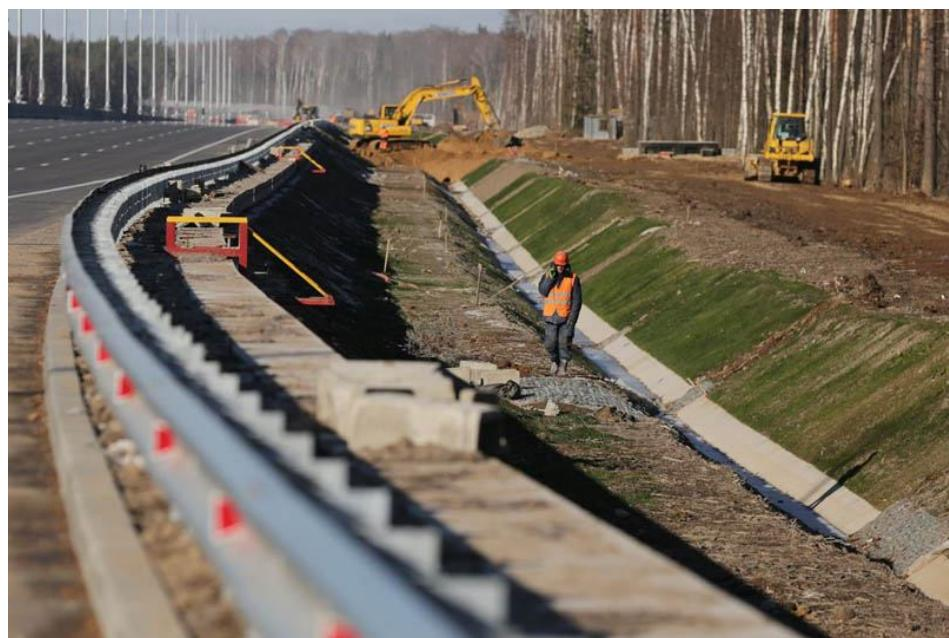
Рис. 5.11. Устройство водоотводной канавы для обеспечения водоотвода
