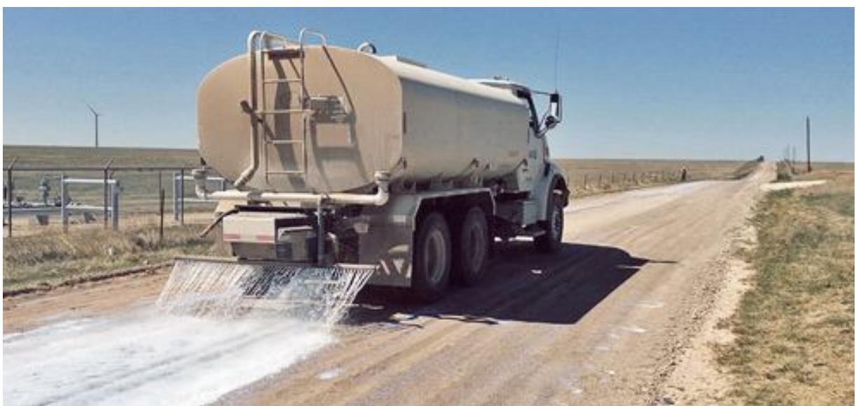
Рис. 5.40. Обеспыливание на дорогах с переходным и низшим типом покрытия
