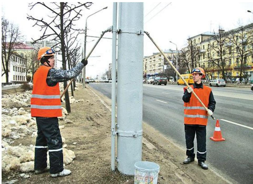
Рис. 5.43. Покраска опор линий электроосвещения
