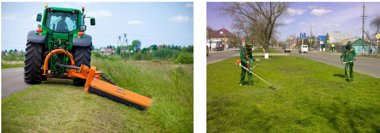
Рис. 5.53. Скашивание травы на откосах и разделительной полосе
