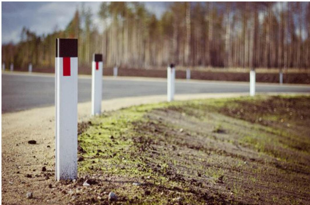
Рис. 5.23. Сигнальные столбики на примыкании к автомобильной дороге
