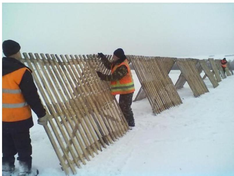
Рис. 5.55. Установка снегозащитных щитов
