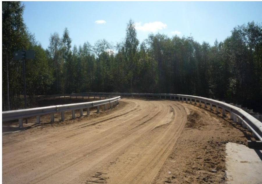
Рис. 5.25. Барьерное (защитное) ограждение на дороге
