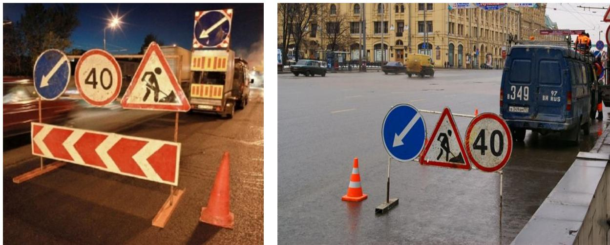
Рис. 5.37. Установка временных дорожных знаков и конусов при ведении ремонтных работ
