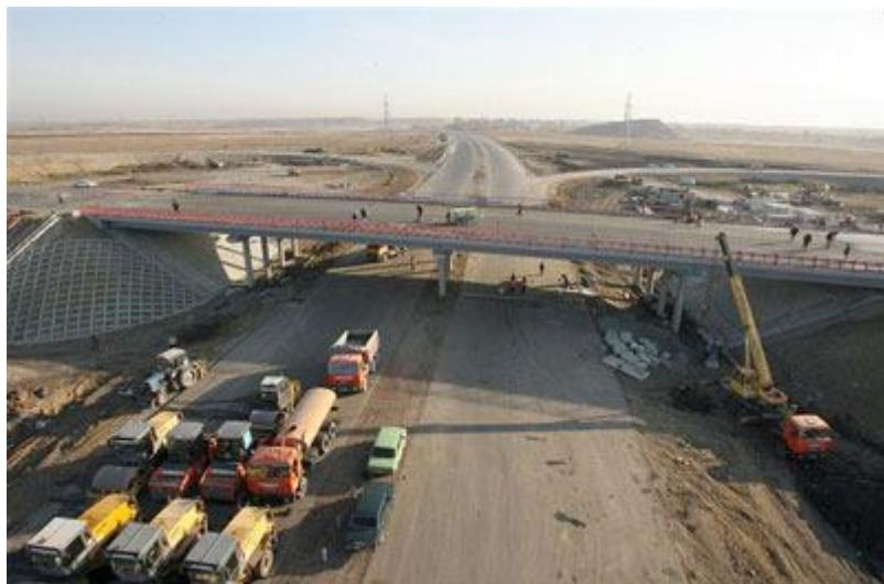
Рис. 5.1. Строительство транспортной развязки
