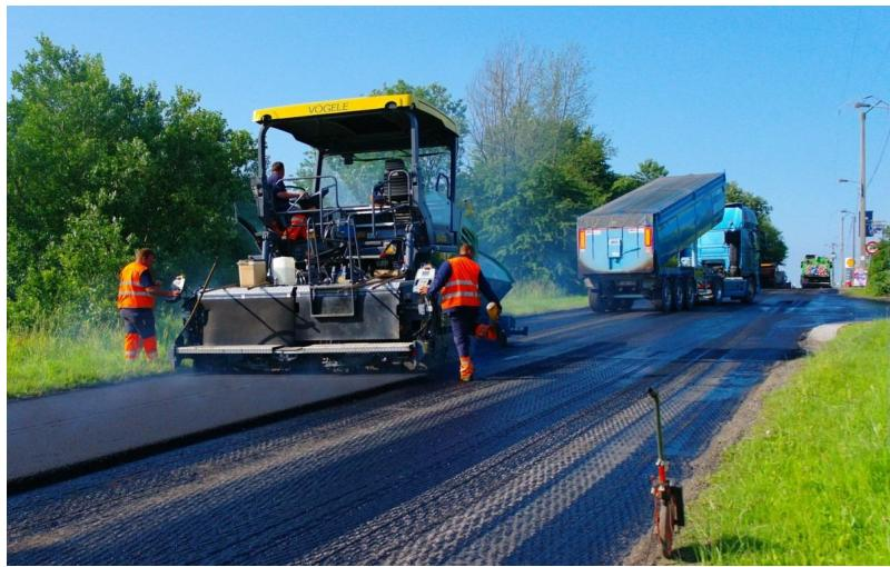
Рис. 5.2. Укладка асфальтобетонного покрытия
