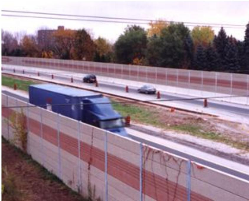
Рис. 5.16. Шумозащитные экраны на автомобильных дорогах
