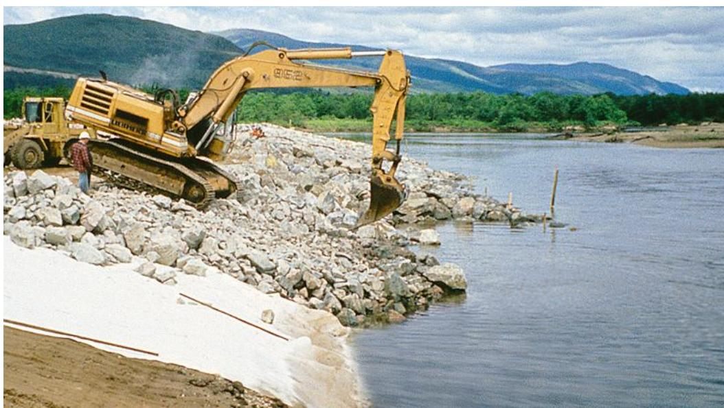
Рис. 5.22. Укрепление берега реки щебнем
