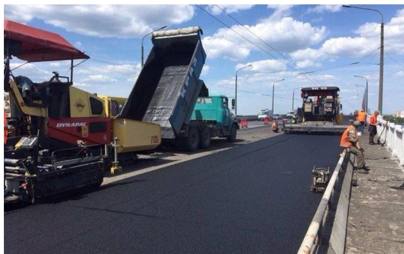
Рис. 5.31. Укладка асфальтобетонного покрытия на мосту
