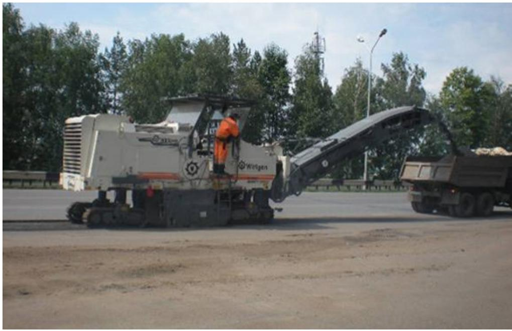
Рис. 5.12. Срезка (фрезерование) существующего асфальтобетонного покрытия при капитальном ремонте участка дороги
