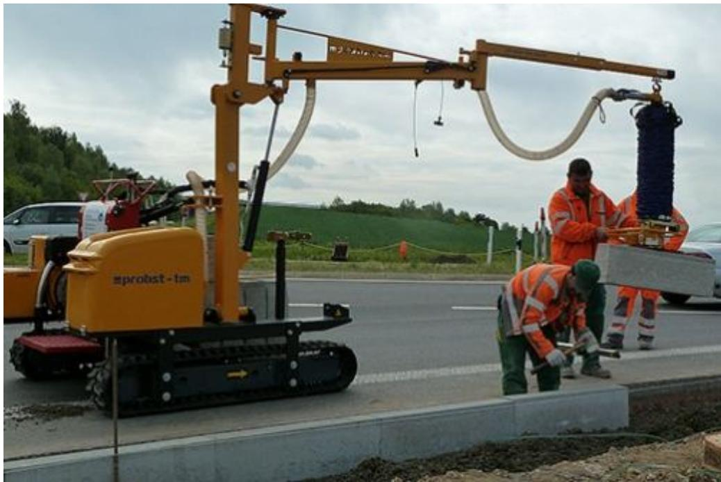
Рис. 5.28. Укладка бордюрного камня с помощью универсального укладчика
