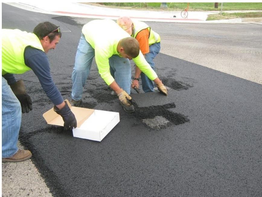
Рис. 7.6. Отбор вырубки из асфальтобетонного покрытия
