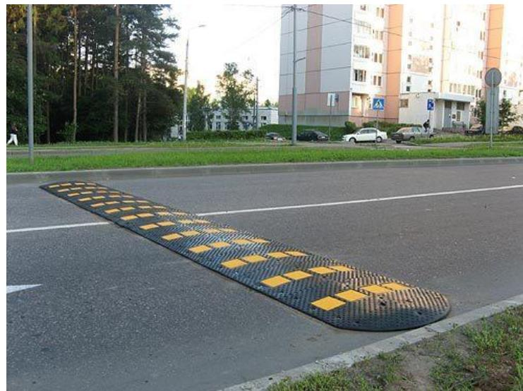
Рис. 5.61. Устройство «лежачего полицейского» для обеспечения безопасности пешеходов
