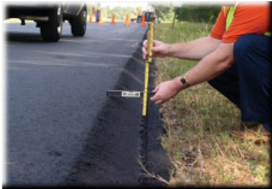
Рис. 7.5. Контроль толщины асфальтобетонного слоя
