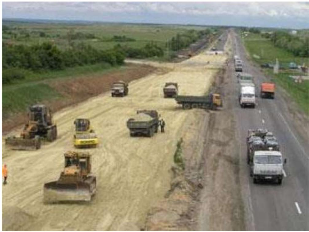
Рис. 5.10. Строительство дополнительных полос движения на автомобильной дороге
