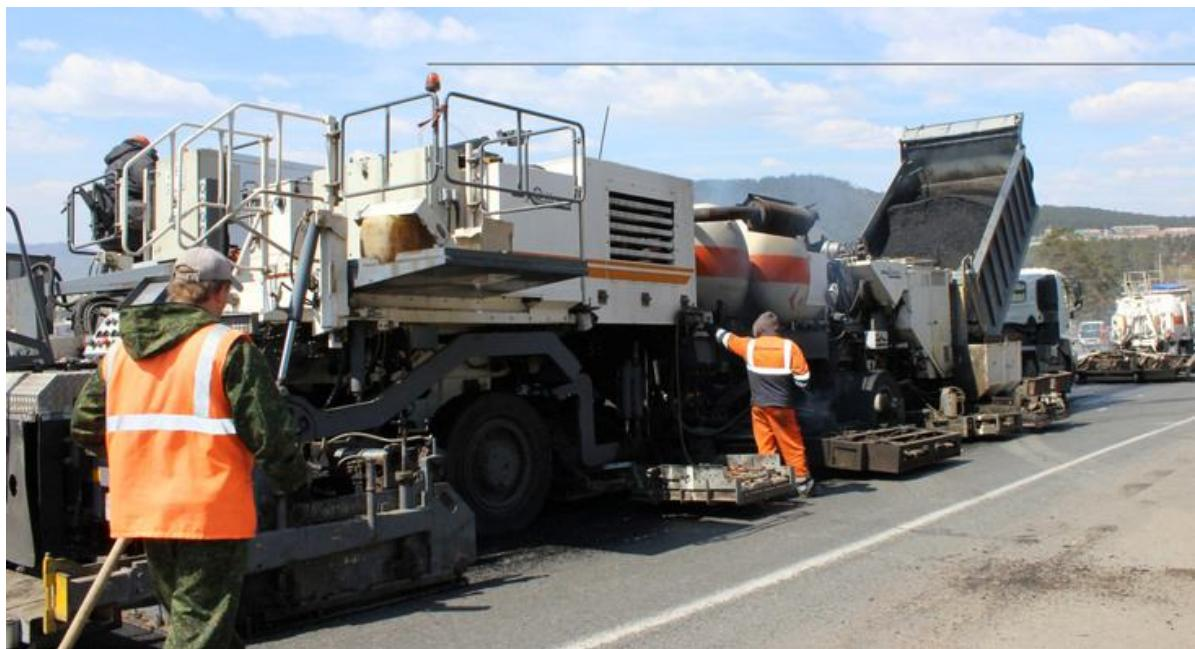
Рис. 5.13. Термовосстановление покрытия с использованием комплекса Remixer
