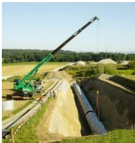
Рис. 5.4. Монтаж водопропускной трубы
