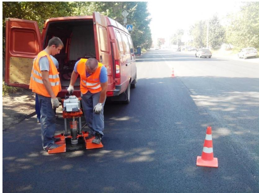
Рис. 7.2. Контроль качества уплотнения асфальтобетонного слоя
