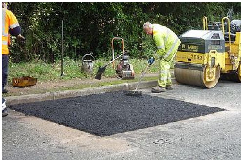
Рис. 5.26. Ямочный ремонт асфальтобетонного покрытия
