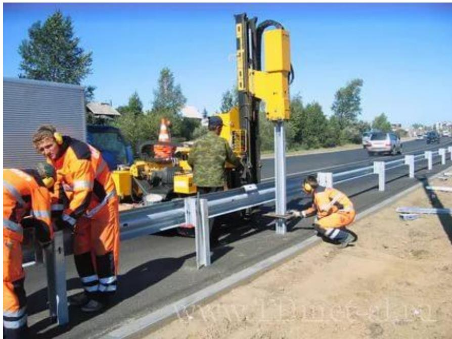
Рис. 5.15. Устройство барьерного ограждения
