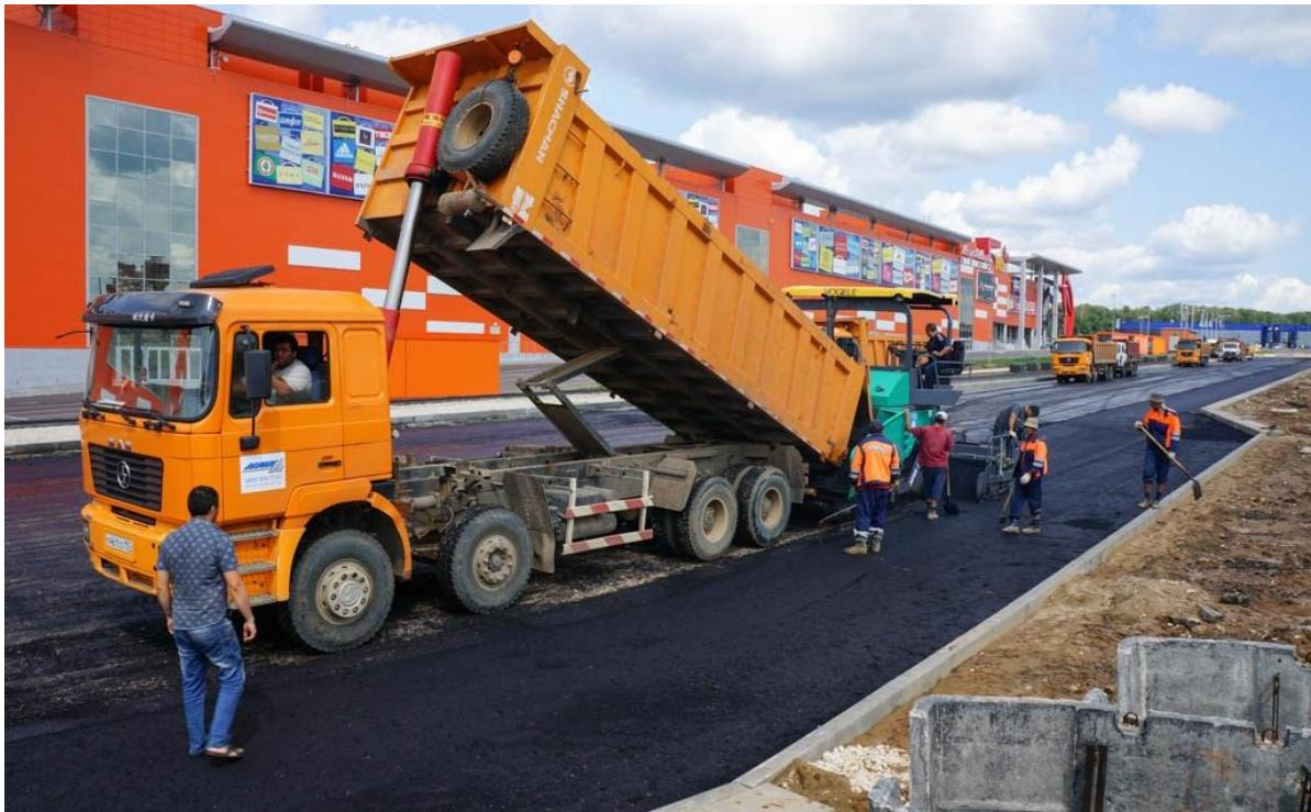
Рис. 5.14. Укладка асфальтобетонного покрытия на стоянке автомобилей
