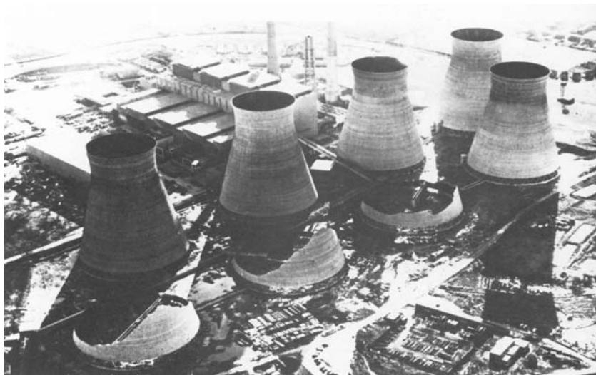
Рис. 12.21. Разрушение градирен на ТЭС Феррибридж (Англия)
