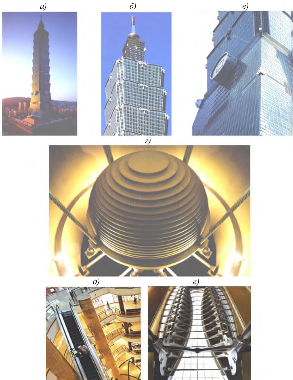
Рис. 3. Практическое использование инерционной массы, выполняющей функцию «гасителя» сейсмического колебания во время землетрясения на примере 101-этажного небоскреба Тайбэй-101, высотой 1671 фут или 509 метров, возведенного в 2004 году по проекту архитектора китайского происхождения Чан-Юн-Ли, расположенного в столице Тайваня - городе Тайбэй, в Китайской Республике:
