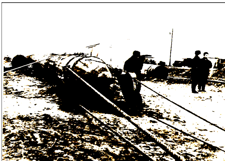
Рис. 11.3. Конусообразная заглушка дюкера со шкивом для закрепления тросов
