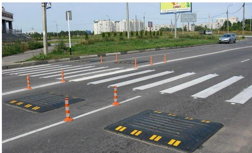
Рисунок 5.8 – Пример обустройства пешеходного перехода ТСРД
