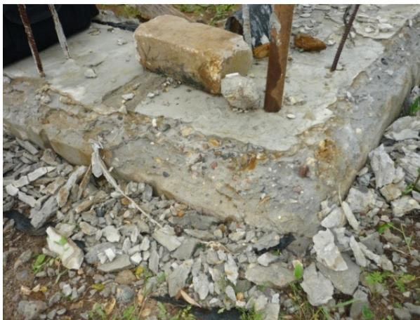
**Рис. 2.6. Разрушение бетона по краям обреза фундамента**
