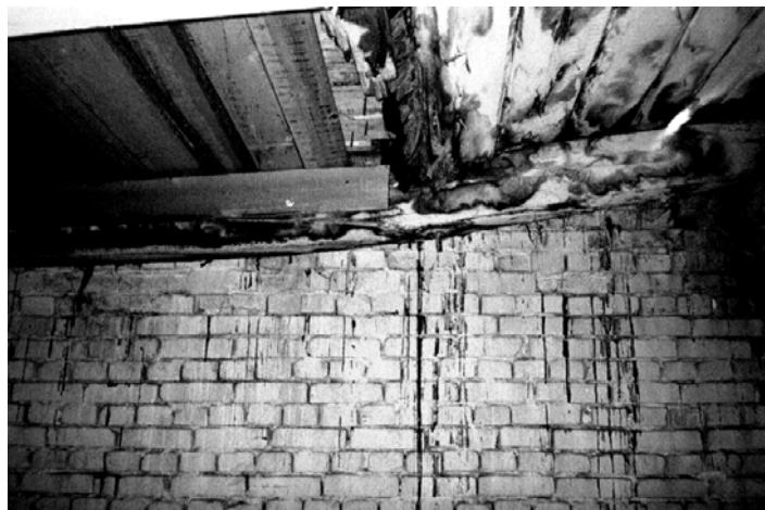
**Рис. 3.13. Гниение и излом деревянных конструкций у торцовых стен зданий**
