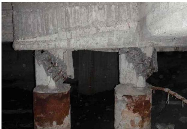
**Рис. 2.5.** Разрушение опорных частей столбчатого монолитного фундамента
