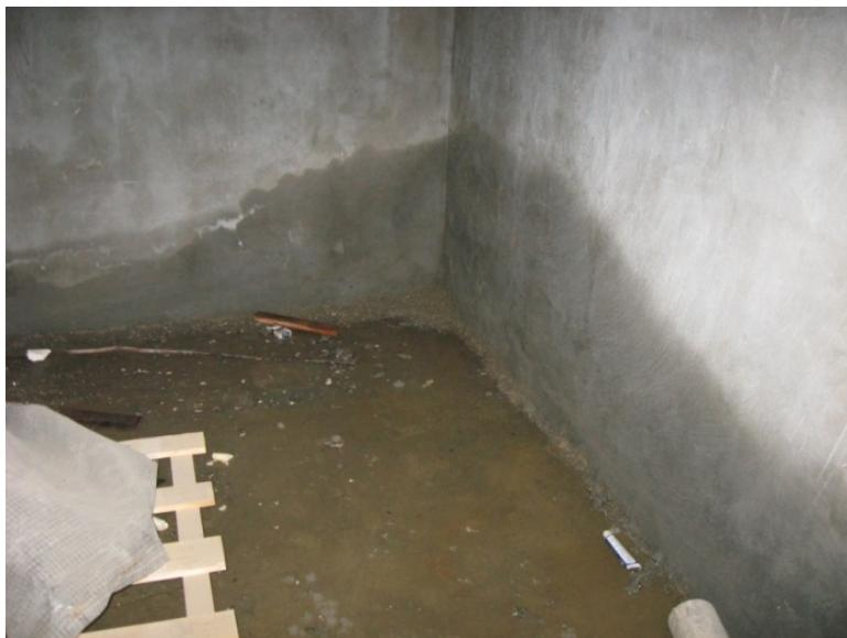
**Рис. 2.11. Затопление подвала вследствие некачественно выполненной гидроизоляции**
