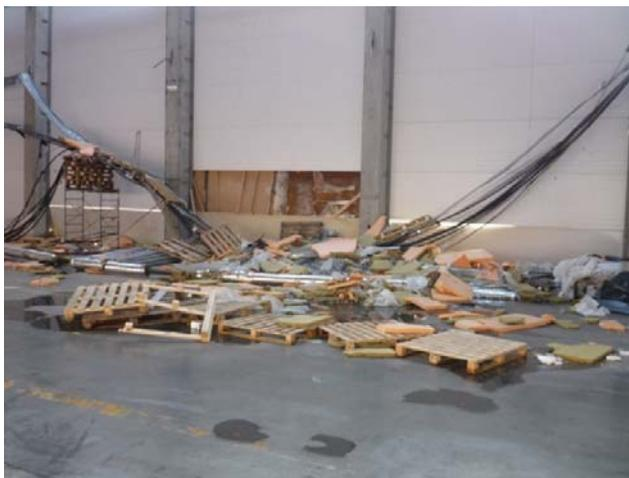
**Рис. 3.10. Обрушение металлической конструкции кровли**
