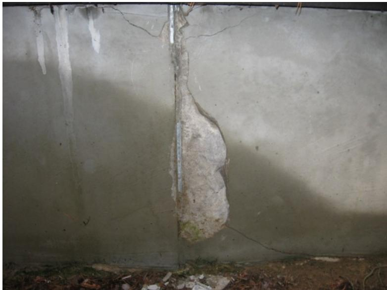
**Рис. 2.9. Разрушение стен подвала вследствие систематических протечек**
