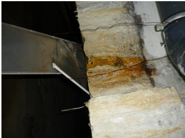
**Рис. 3.5. Протечки железобетонной чаши бассейна являются следствием нарушения технологии устройства технологических швов при бетонировании**
