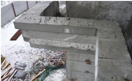
**Рис. 3.3. Низкое качество бетонных работ**
