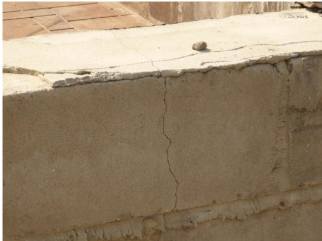
**Рис. 2.4. Сквозная трещина в цокольной стене здания**
