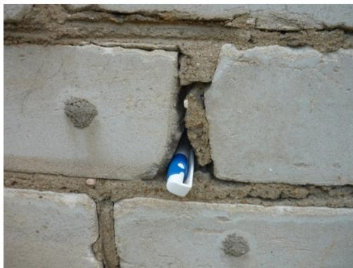
**Рис. 3.7. Сквозные трещины по швам кирпичной кладки**
