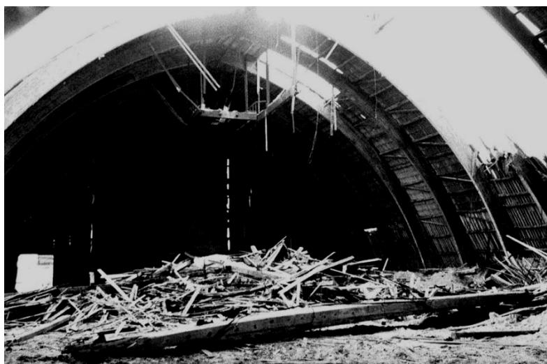
**Рис. 3.14. Общий вид склада из kleеных деревянных конструкций после аварии из-за сверхнормативной односторонней снеговой нагрузки**
