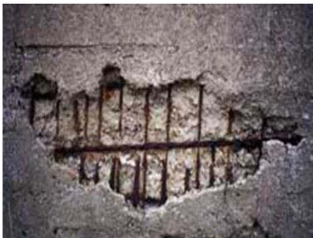
**Рис. 2.3. Выбоины и углубления в бетоне**
