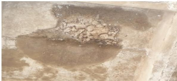
**Рис. 3.2. Образование раковины при бетонировании**
