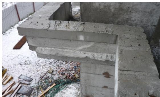
**Рис. 3.3. Низкое качество бетонных работ**
