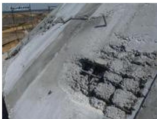
**Рис. 2.14. Пустоты в бетонной конструкции, оголение арматурного каркаса**
