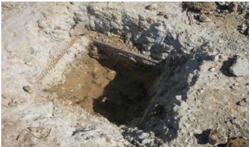
**Рис. 2.15. Фундамент не имеет достаточной глубины заложения**
