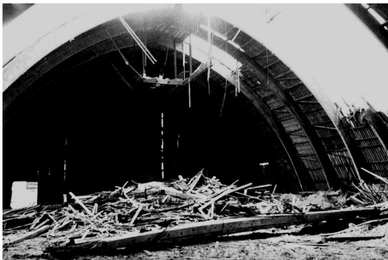
**Рис. 3.14. Общий вид склада из клееных деревянных конструкций после аварии из-за сверхнормативной односторонней снеговой нагрузки**
