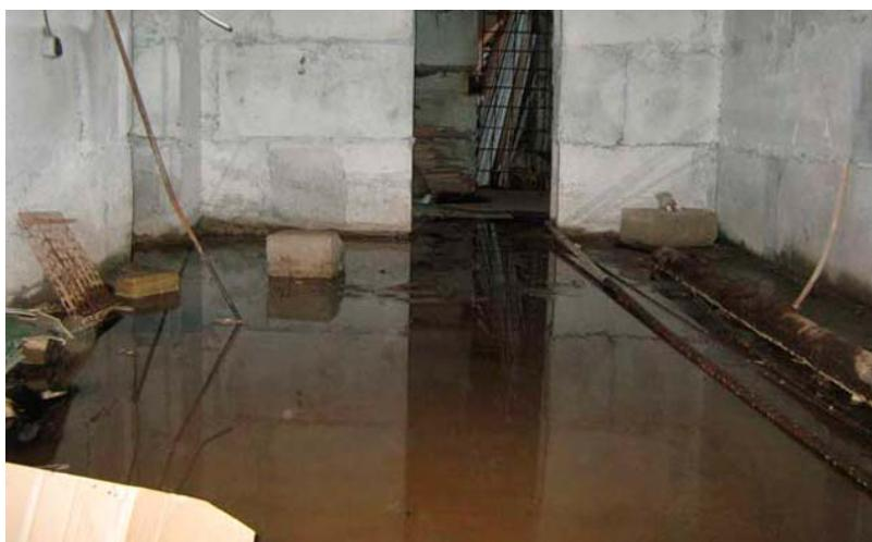
**Рис. 2.12. Затопление подвала вследствие неправильного оборудования дренажной системы на этапе строительства**
