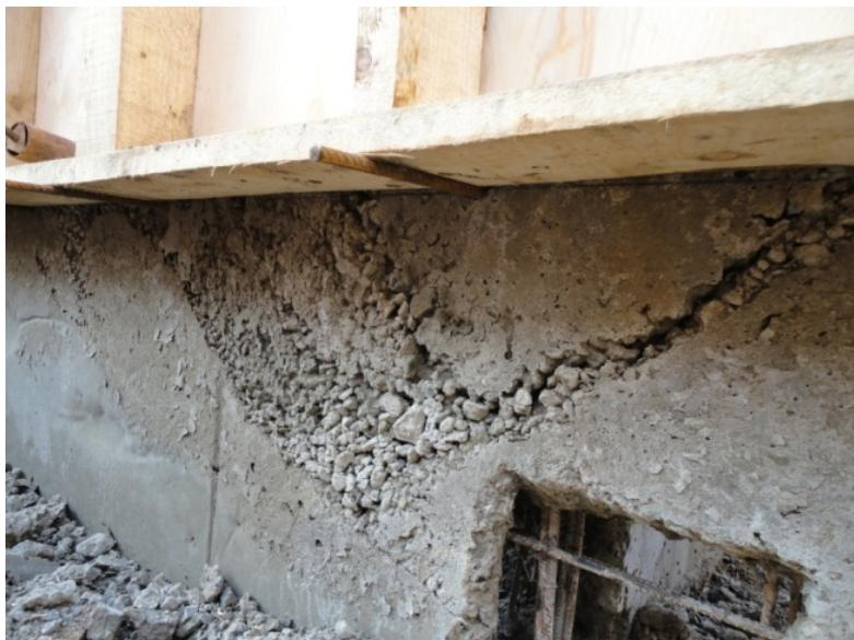
**Рис. 2.1. Раковины в железобетонных монолитных фундаментных стенах**
