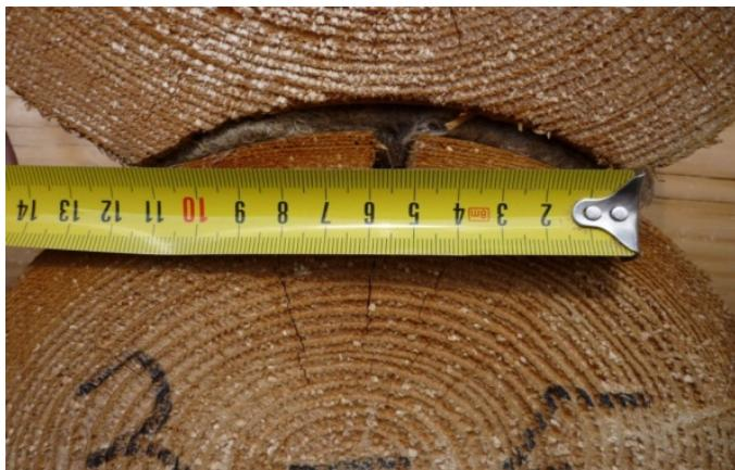
Рис. 3.15. Замеры толщины швов между венцами бревенчатой стены
