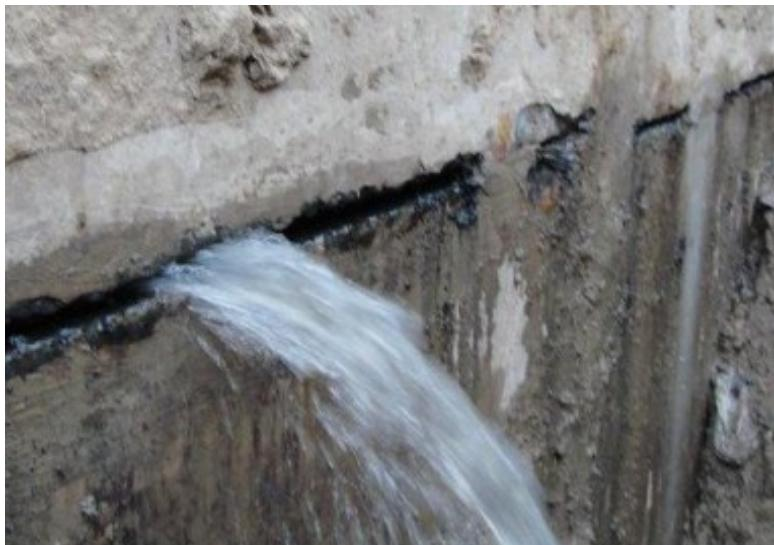
**Рис. 2.10. Протечки грунтовых вод**
