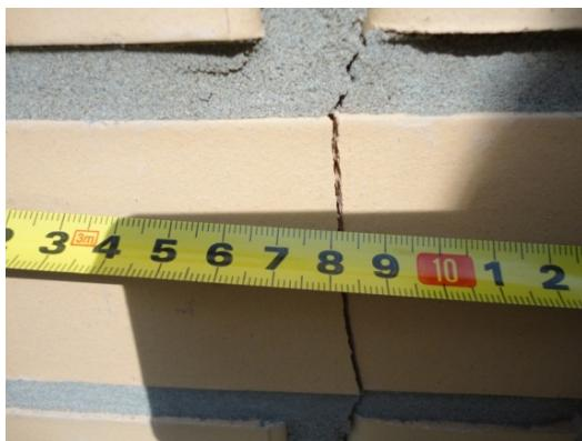
Рис. 3.6. Трещины в кирпичной кладке
