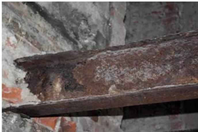
**Рис. 3.12. Биоповреждение стальной балки**
