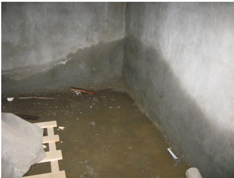
**Рис. 2.11. Затопление подвала вследствие некачественно выполненной гидроизоляции**
