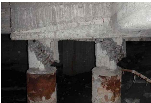
**Рис. 2.5. Разрушение опорных частей столбчатого монолитного фундамента**
