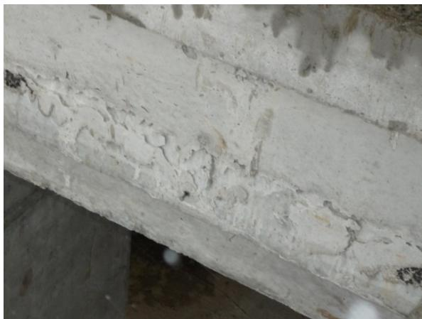
**Рис. 3.4. Наплывы бетона**
