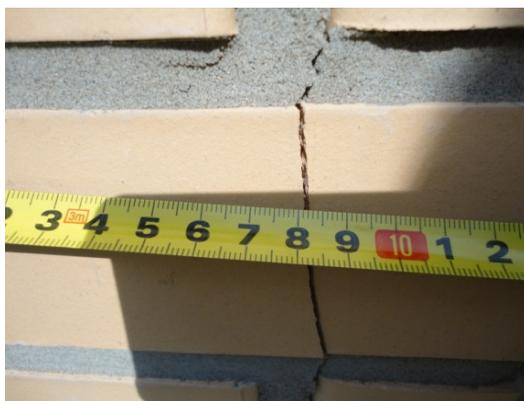
Рис. 3.6. Трещины в кирпичной кладке
