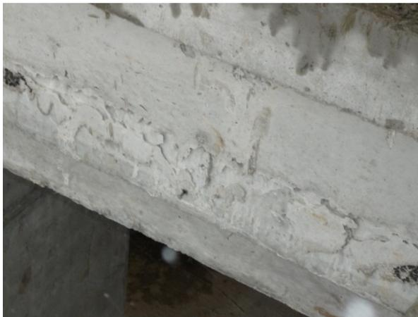
**Рис. 3.4. Наплывы бетона**
