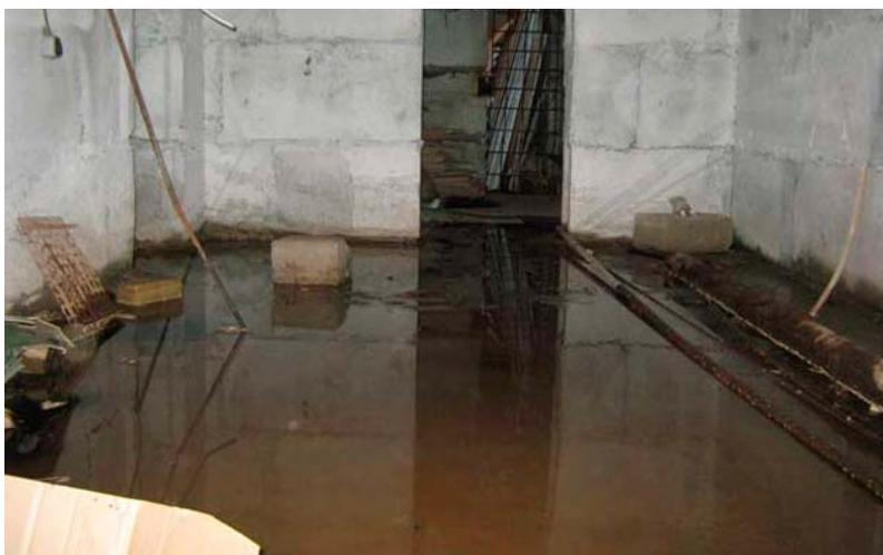
**Рис. 2.12. Затопление подвала вследствие неправильного оборудования дренажной системы на этапе строительства**
