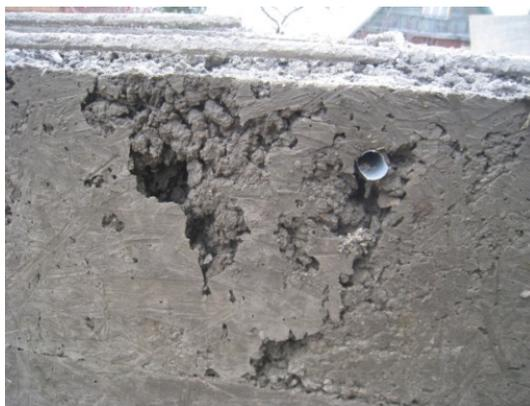
**Рис. 2.13. Глубокие раковины в конструкции железобетонного монолитного ленточного фундамента**
