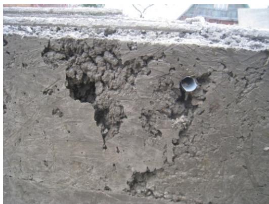
**Рис. 2.13. Глубокие раковины в конструкции железобетонного монолитного ленточного фундамента**
