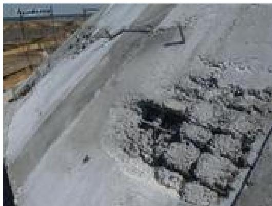
**Рис. 2.14. Пустоты в бетонной конструкции, оголение арматурного каркаса**
