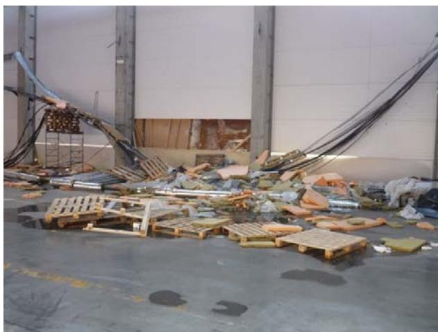
Рис. 3.10. Обрушение металлической конструкции кровли
