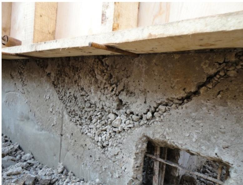
**Рис. 2.1. Раковины в железобетонных монолитных фундаментных стенах**
