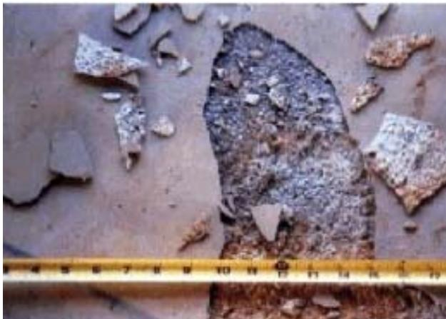
**Рис. 2.2. Расслоение железобетонной конструкции**
