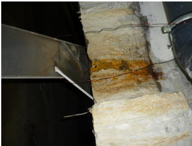
**Рис. 3.5. Протечки железобетонной чаши бассейна являются следствием нарушения технологии устройства технологических швов при бетонировании**
