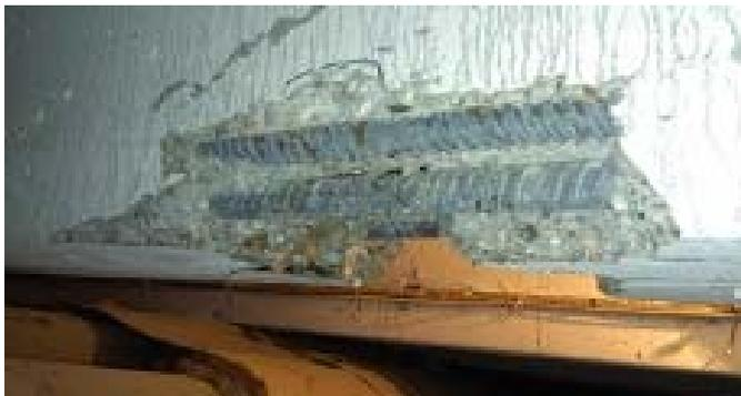
**Рис. 3.1. Оголение арматуры железобетонной балки вследствие механического повреждения**
