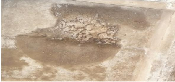
**Рис. 3.2. Образование раковины при бетонировании**
