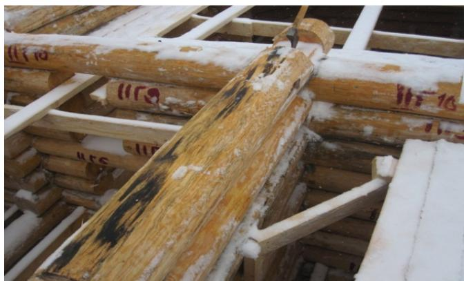
**Рис. 3.16. На поверхности бревна видны следы гниения**
