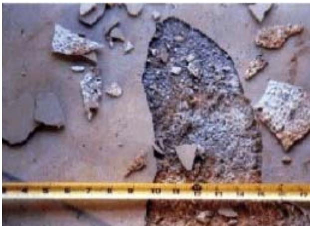
**Рис. 2.2. Расслоение железобетонной конструкции**
