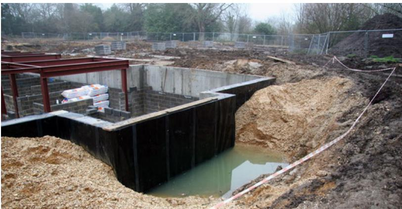
**Рис. 2.8. Неправильный отвод грунтовых вод**
