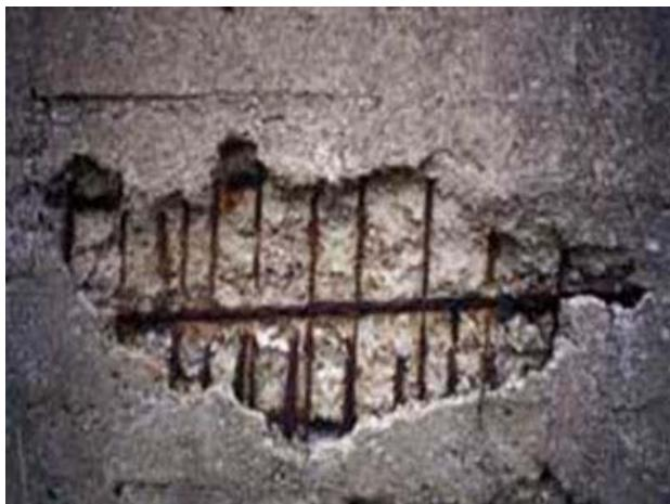
**Рис. 2.3. Выбоины и углубления в бетоне**
