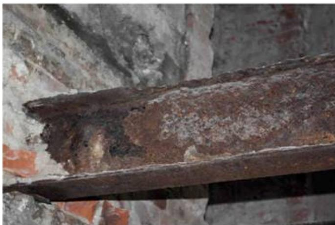
**Рис. 3.12. Биоповреждение стальной балки**
