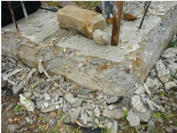
**Рис. 2.6. Разрушение бетона по краям обреза фундамента**
