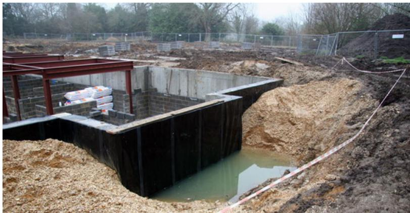
**Рис. 2.8. Неправильный отвод грунтовых вод**
