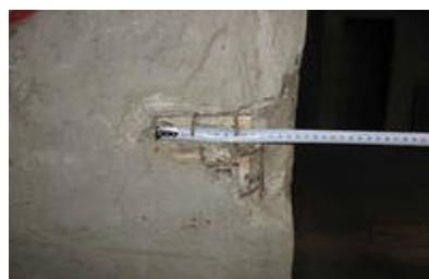
**Рис. 2.22. Вскрытие конструкции с целью определения наличия, шага и диаметра арматуры**
