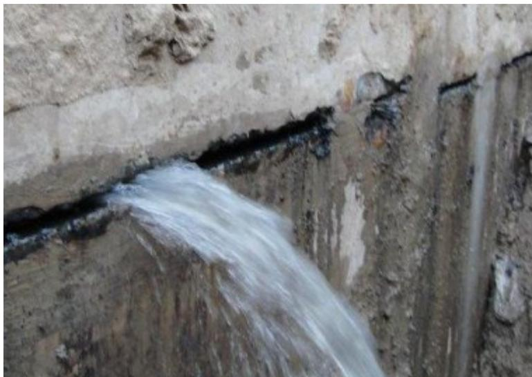
**Рис. 2.10.** Протечки грунтовых вод
