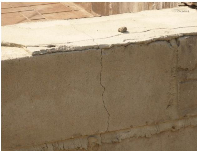
**Рис. 2.4.** Сквозная трещина в цокольной стене здания
