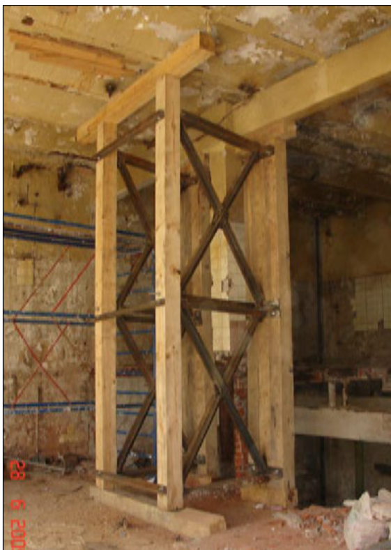
Рисунок 8 – Конструкции подкрепления стальной колонны 1-го этажа, на пересечении осей «Б»/«3»
