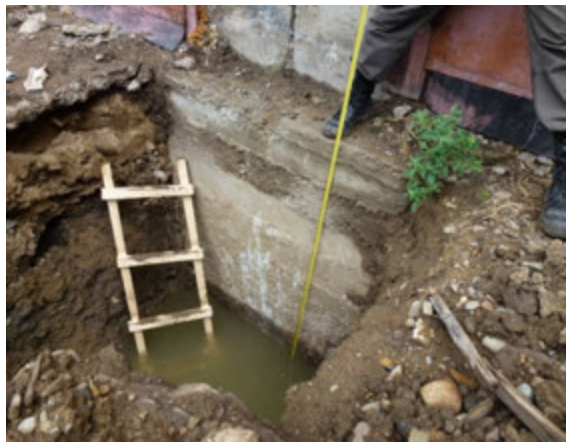
Рисунок 4 – Подтопление фундамента грунтовыми водами и деформационные повреждения стены
