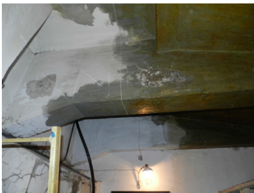
Рисунок 9 – Контрольные участки в сухой и промасленной зонах балки
