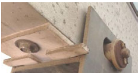
Рисунок 11 – Точечная коррозия алюминия на второстепенной балке светопрозрачной панели и следы протечек в виде следов коррозии в местах крепления обшивки
