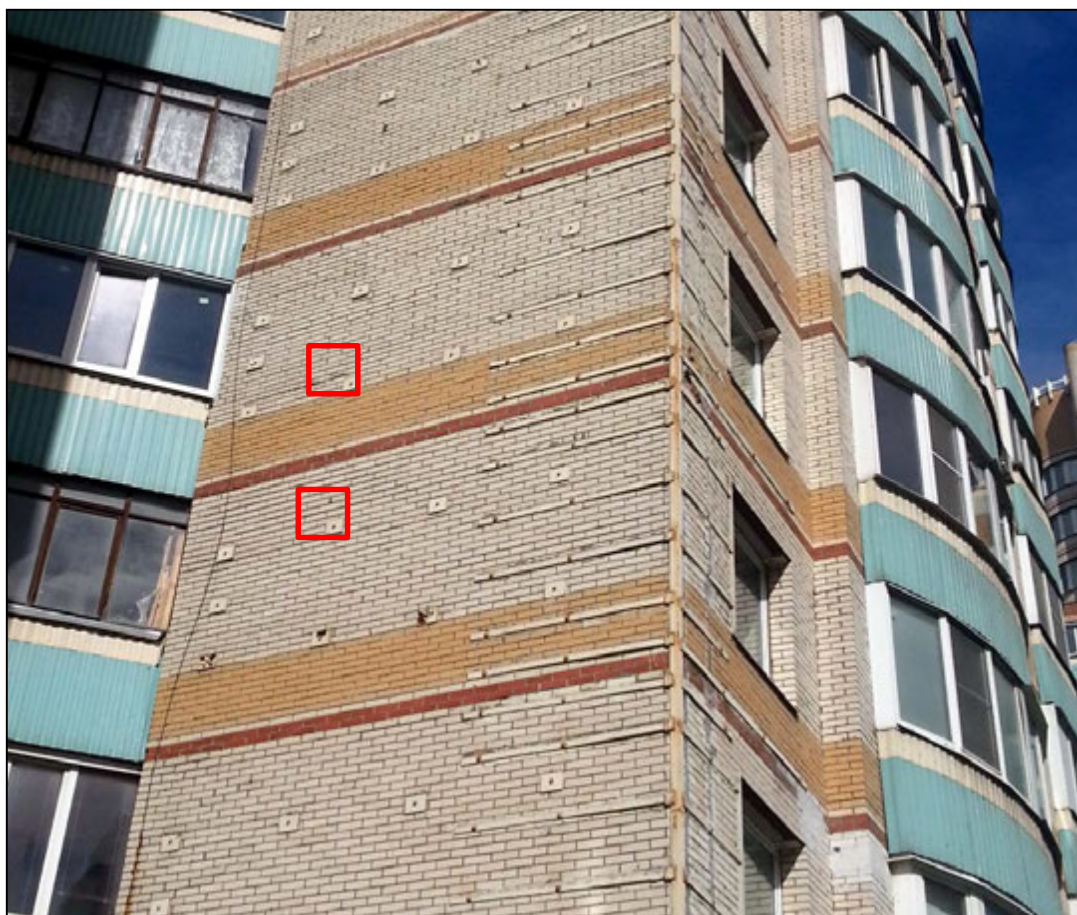
Рисунок 9 – Усиление угла здания металлическими обоями. Красными квадратами отмечены места установки анкеров
