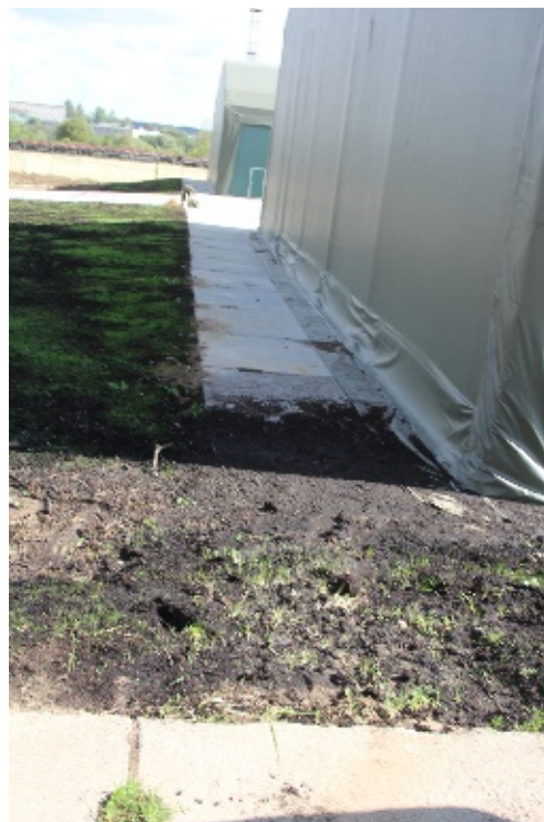
Намывание грунта на площадку
