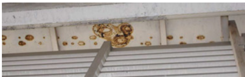
Рисунок 11 – Точечная коррозия алюминия на второстепенной балке светопрозрачной панели и следы протечек в виде следов коррозии в местах крепления обшивки
