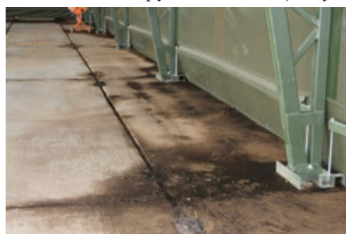
Намывание грунта на площадку внутрь ангара
