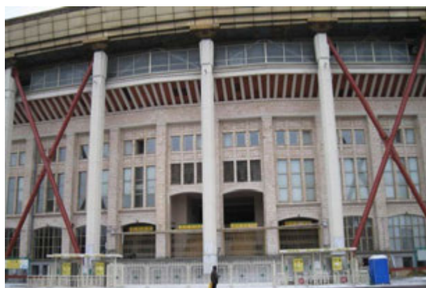
Рисунок 17–Установленные временные вертикальные связи между существующими колоннами
