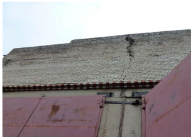
Рисунок 4 – Подтопление фундамента грунтовыми водами и деформационные повреждения стены
