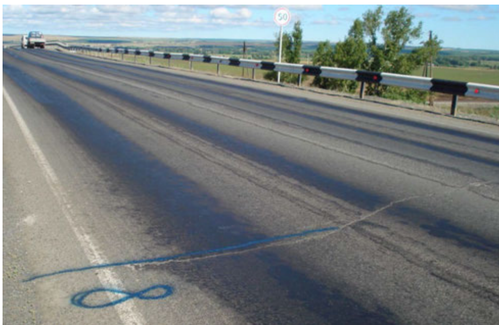
Рисунок 2 – Поперечный створ будущей скважины № 8 и прохода георадара
