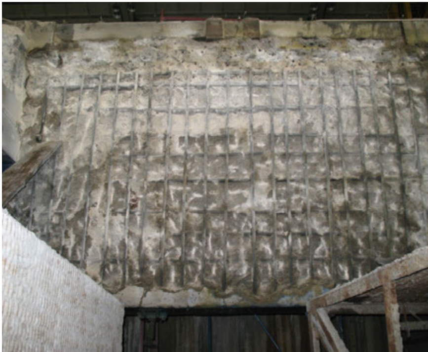
Рисунок 4 – Результат удаления промасленного защитного слоя бетона балки
