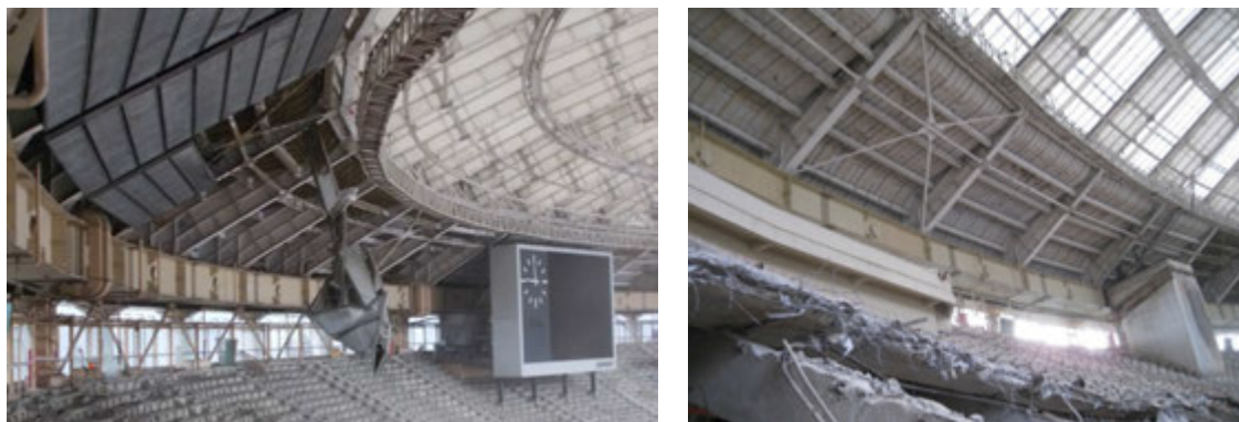
Рисунок 5 – Демонтаж обшивки и вскрытые элементы конструкций под непрозрачным покрытием БСА
