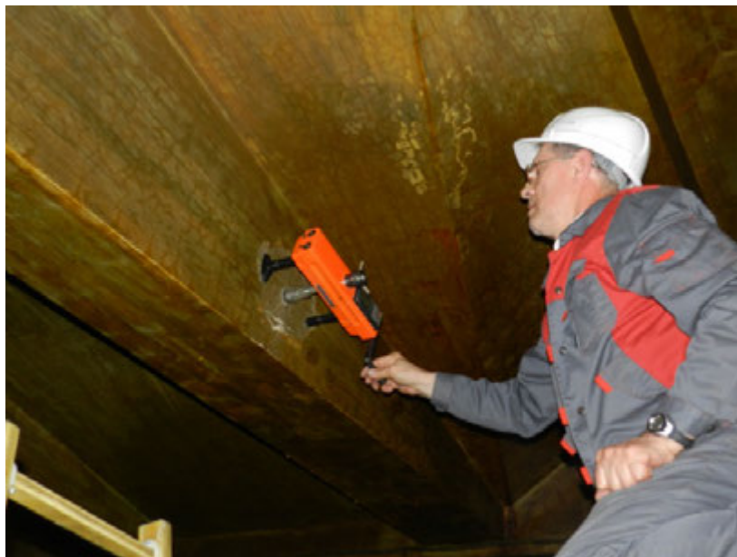
Рисунок 8 – Контроль прочности бетона прибором «Оникс-ОС»
