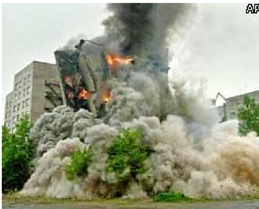
Рисунок 5 – Обрушение здания на ул. Двинской в Санкт-Петербурге в 2002 году
