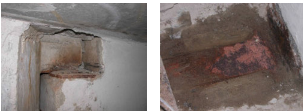
Рисунок 1 – Конструкция стыка ригеля перекрытия с колонной
