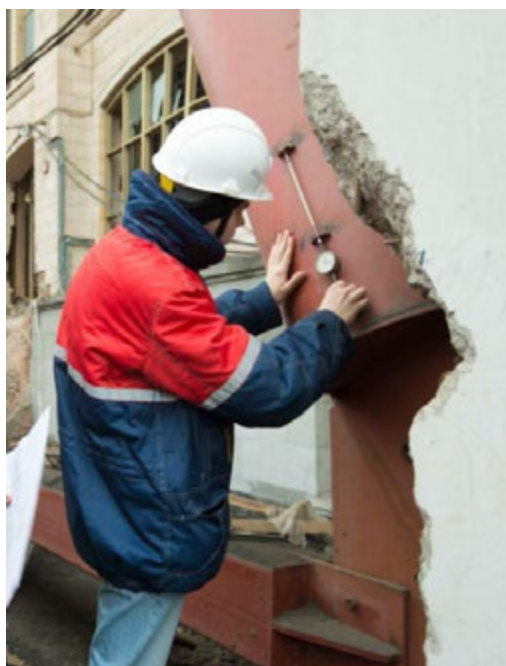
Рисунок 21 – Измерение деформаций в вертикальных связях во время реконструкции
