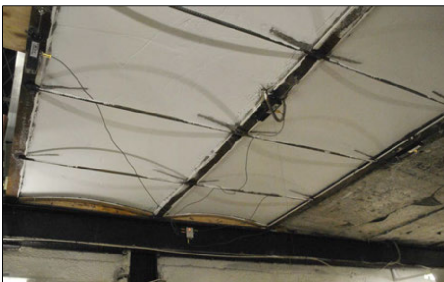
Рисунок 10 – Вид на перекрытие снизу
