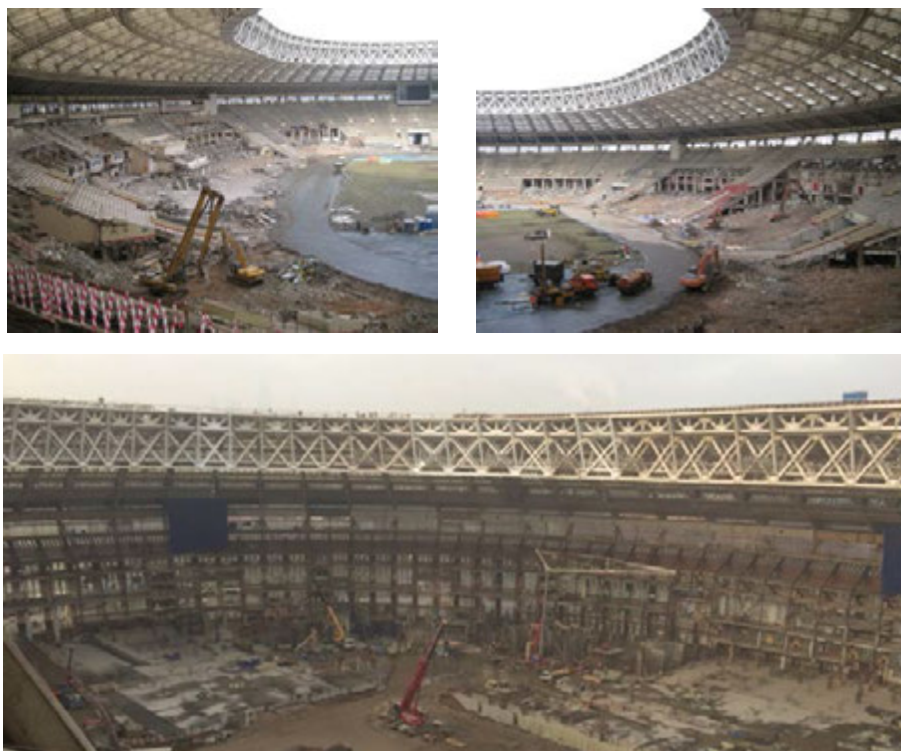
Рисунок 4 – Демонтаж трибун и вид на последний пролёт демонтируемого каркаса трибун
