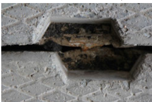
Соединение плит выполнено прихватками
