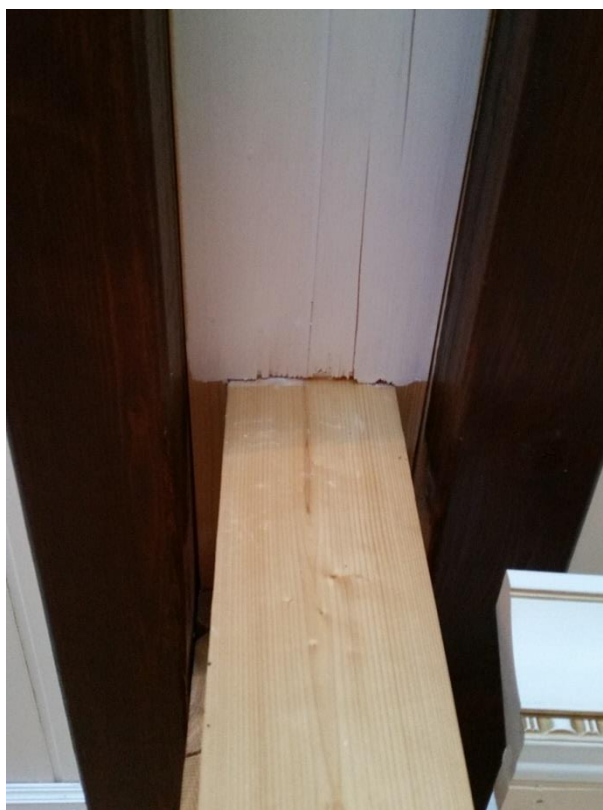
Рисунок 1 – Фотография обследования опорного узла деревянной балки
