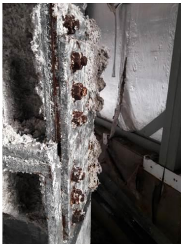
Рисунок 13 – Местная коррозия на торцах накладок, коррозия болтов в стыках колонн 2-го этажа
