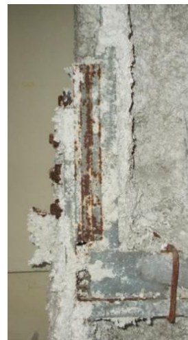
Рисунок 13 – Местная коррозия на торцах накладок, коррозия болтов в стыках колонн 2-го этажа
