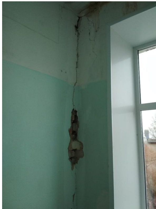
Рисунок 2 – Вертикальные трещины в местах сопряжения продольных несущих и торцевых самонесущих стен
