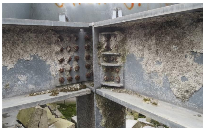
Рисунок 26 – Поверхностная коррозия болтов и гаек в узлах опирания балок на 21-м этаже
