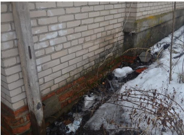
Рисунок 2 – Дефекты цоколя и стен обследуемого объекта
