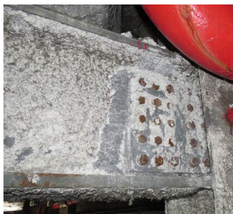
Рисунок 26 – Поверхностная коррозия болтов и гаек в узлах опирания балок на 21-м этаже
