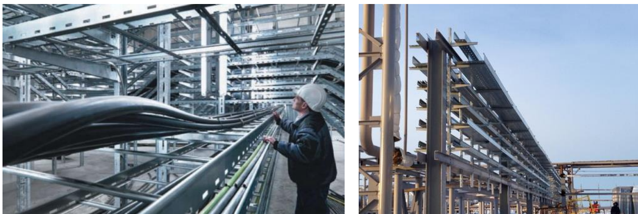
Рисунок 1 – Применение кабельных лотков
