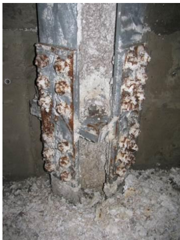
Рисунок 11 – Поверхностная коррозия болтов в узлах на 1-м этаже: а) в стыках колонн; б) в примыкании балки к колонне
