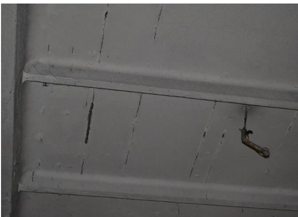
Рисунок 3 – Дефекты перекрытия и железобетонных колонн обследуемого объекта
