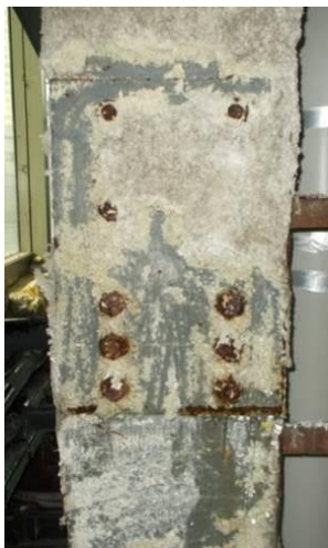
Рисунок 13 – Местная коррозия на торцах накладок, коррозия болтов в стыках колонн 2-го этажа
