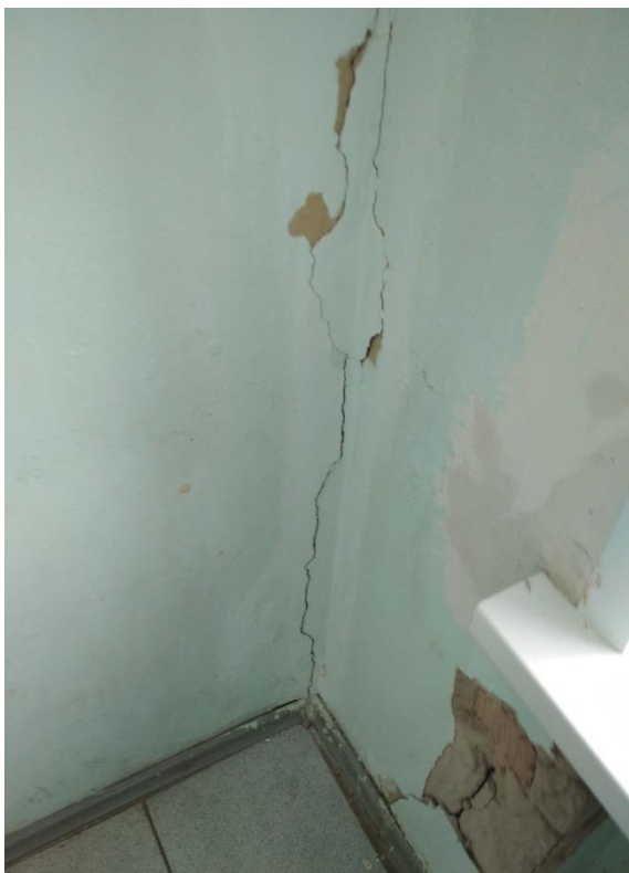
Рисунок 2 – Вертикальные трещины в местах сопряжения продольных несущих и торцевых самонесущих стен
