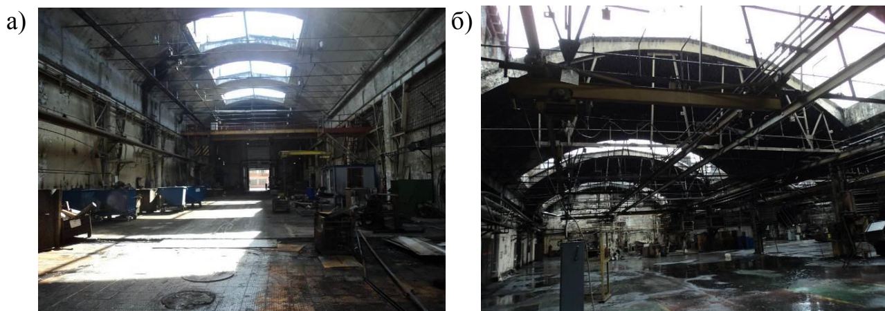
Рисунок 3 – Здание цеха №225 по сборке коробок передач:
