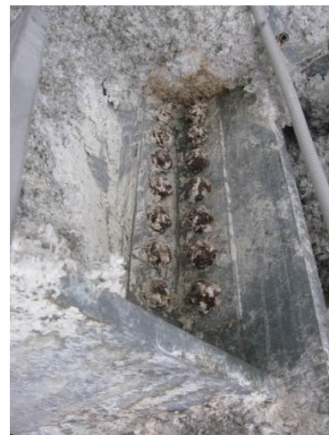
Рисунок 11 – Поверхностная коррозия болтов в узлах на 1-м этаже: а) в стыках колонн; б) в примыкании балки к колонне
