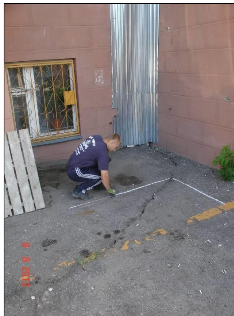
Рисунок 22 – Разметка места вскрытия шурфа №4
