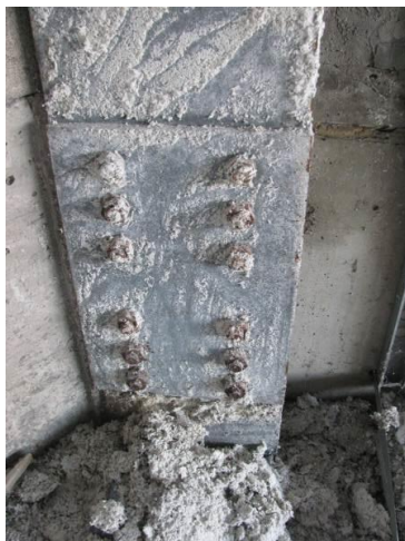
Рисунок 11 – Поверхностная коррозия болтов в узлах на 1-м этаже: а) в стыках колонн; б) в примыкании балки к колонне
