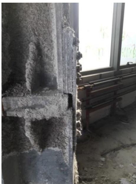
Рисунок 10 – Стык колонн
