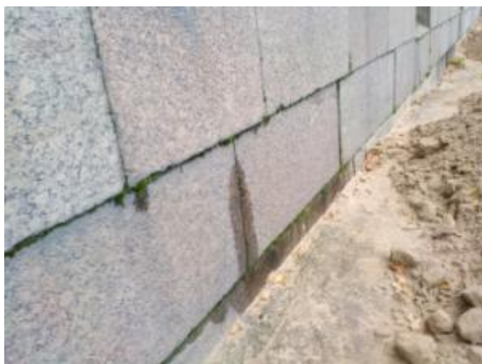
Рисунок 6 - Наружная сторона куртины, обращенная к Неве. Биодеструкторы, в основном, сконцентрированы между плитами
