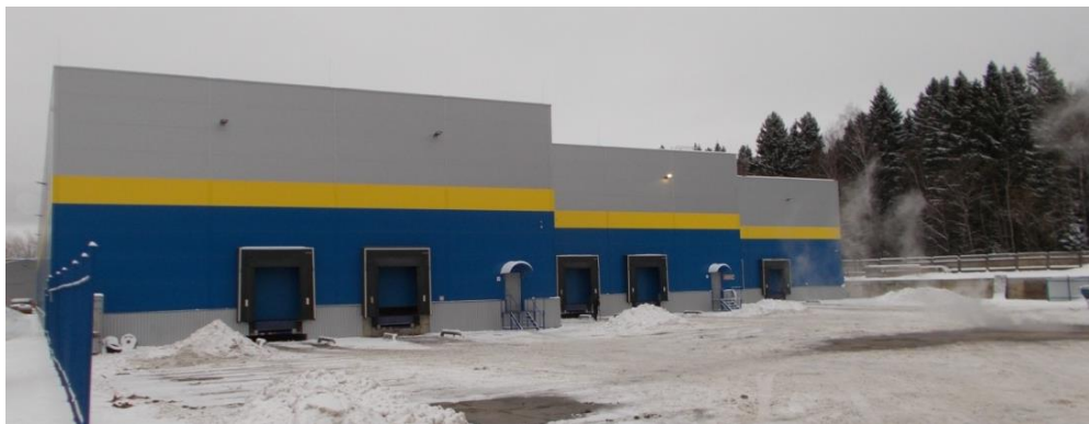
Рисунок 17 – Общий вид склада с торца здания
