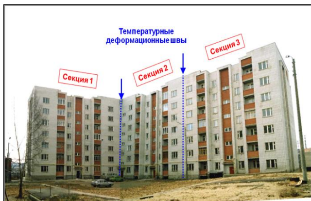
Рисунок 1 - 1997 год. 7-этажный жилой дом на улице Ломоносова в Нижнем Новгороде. Вид со двора
