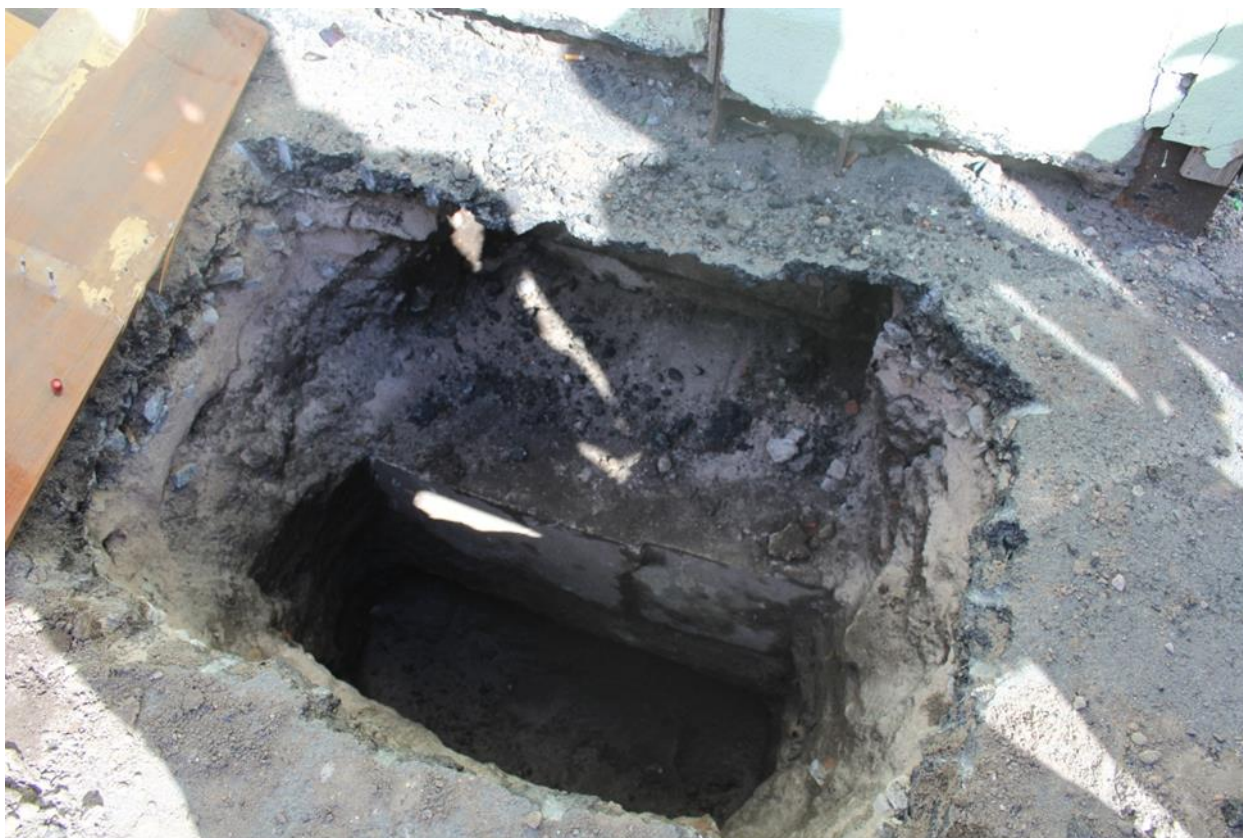
Рисунок 4 –Фундамент под наружной несущей стеной
