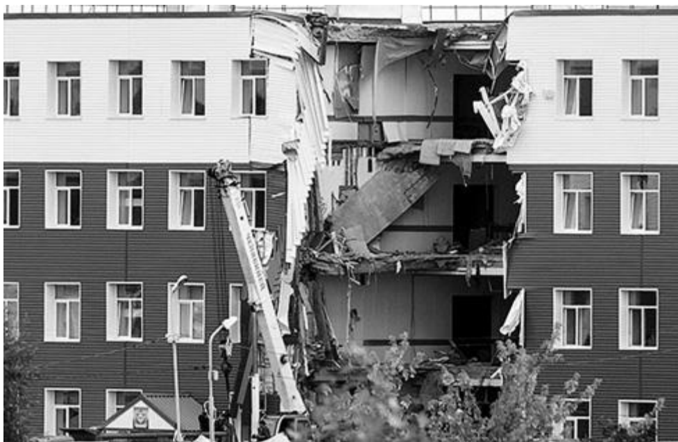
Рисунок 2 – Обрушение казармы 242-го учебного центра подготовки в посёлке Светлом города Омска
