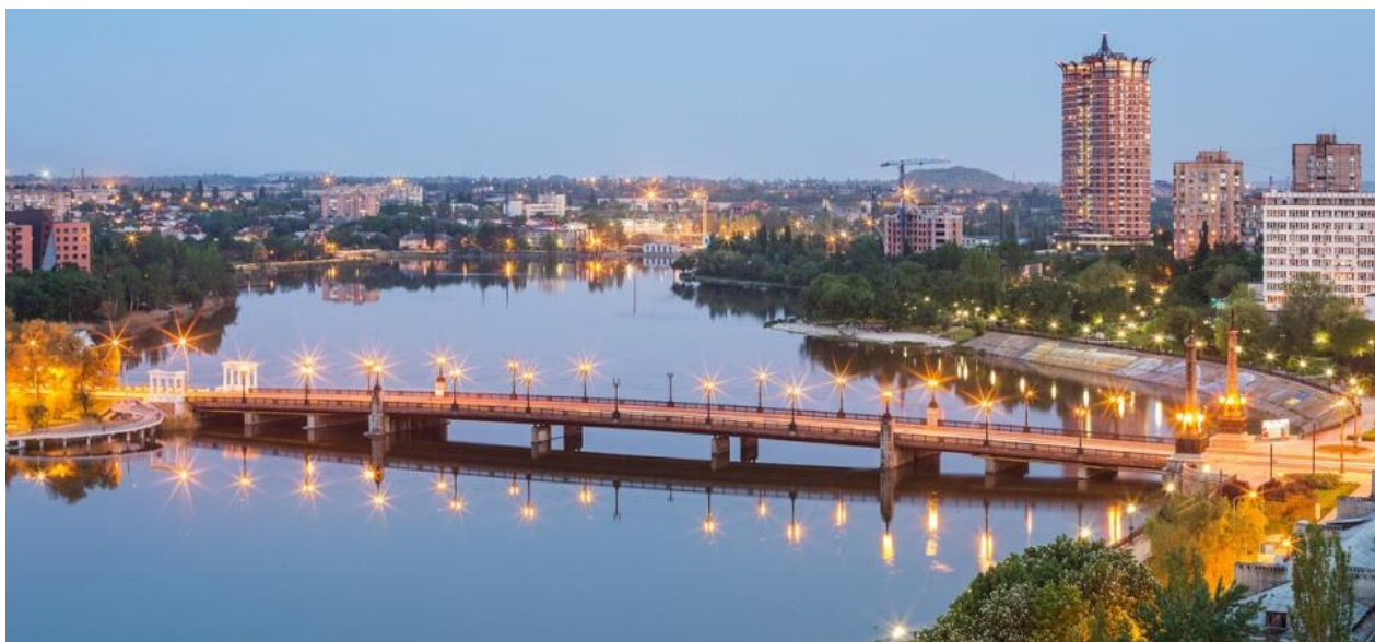
Рисунок 1 - Общий вид моста через р. Кальмиус по проспекту Ильича в г. Донецке
