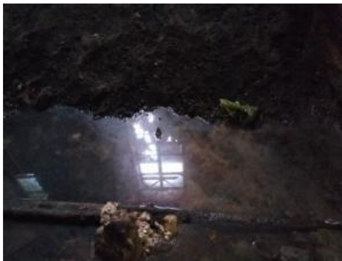
Рисунок 5 - Вода, скопившаяся на полу одного из западных казематов
