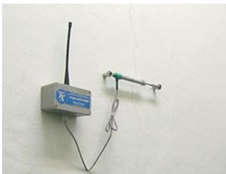
Рисунок 5 – Электронный трещиномер на трещине
