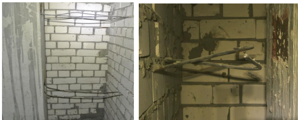
Рисунок 1- Узел крепления наружной стены к каркасу
