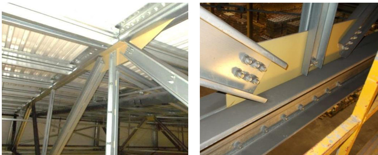
Рисунок 18 – Стропильные фермы покрытия здания склада
