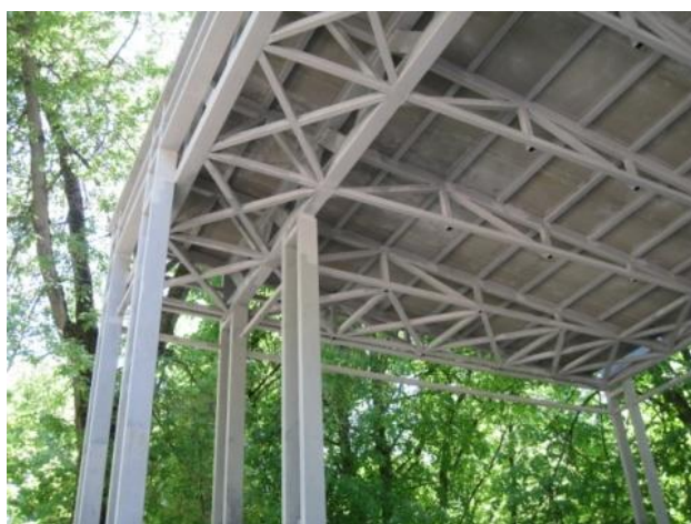
Рисунок 12 – Опираение стропильных на подстропильные фермы по рядам А и Б
