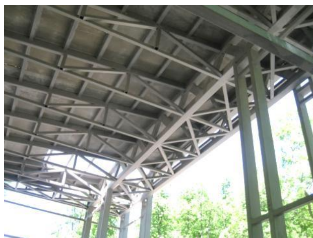
Рисунок 12 – Опираение стропильных на подстропильные фермы по рядам А и Б
