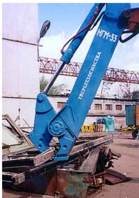
Рис. 1.9. Гидроножницы НГМ-33 ОАО «Тверьтехоснастка» разрезают металлоконструкцию
