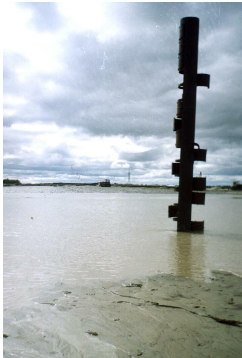
Прудок-отстойник и водосбросной колодец
