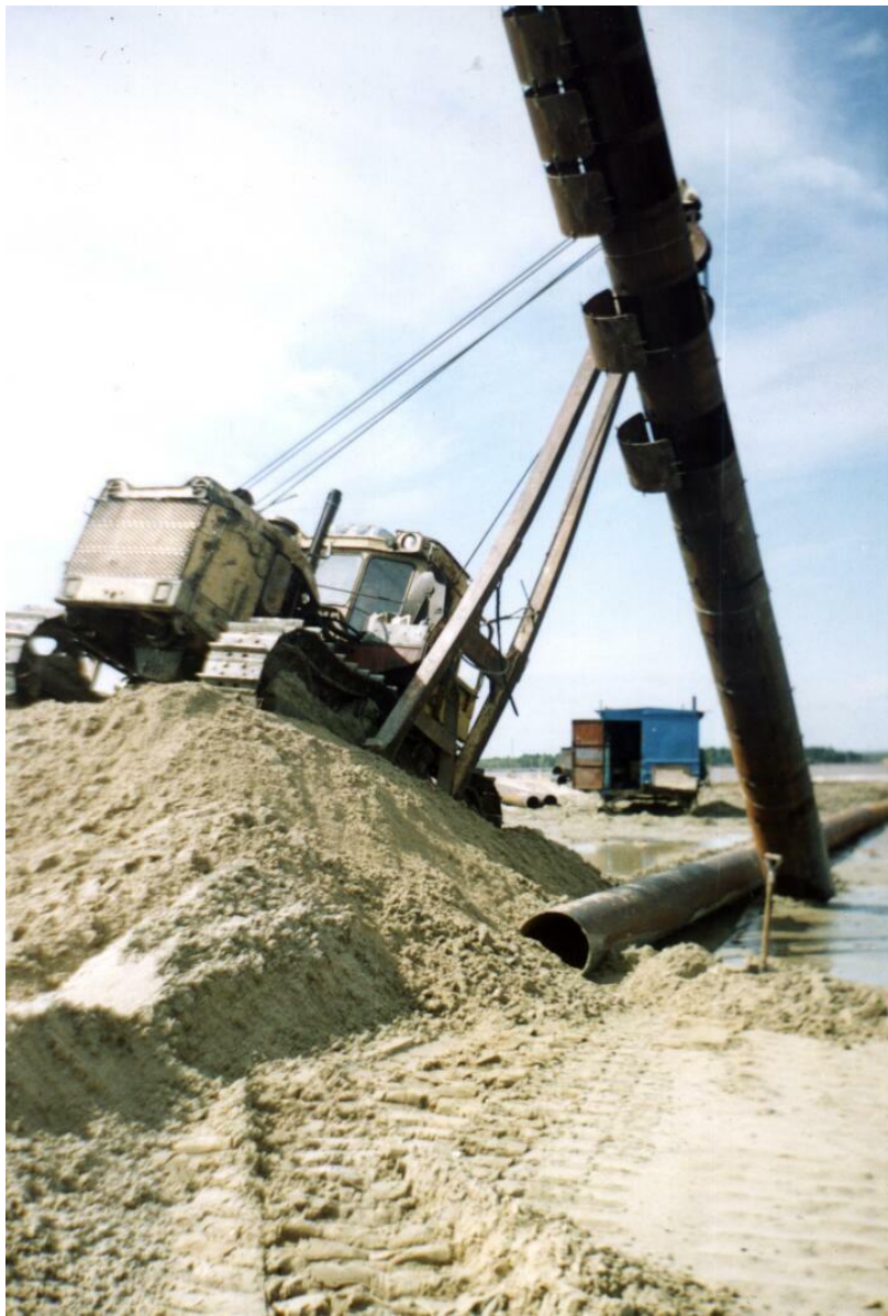
Монтаж водосбросного колодца
