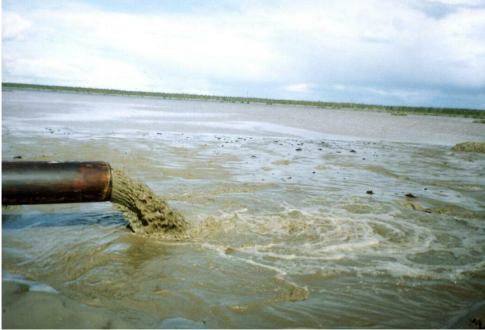
Первоначальная отмывка грунта для обваловки
