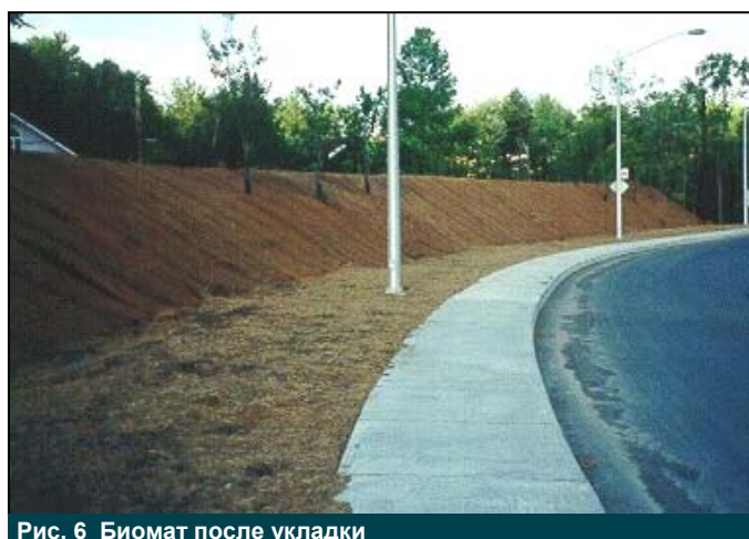
Рис. 6 Биомат после укладки
