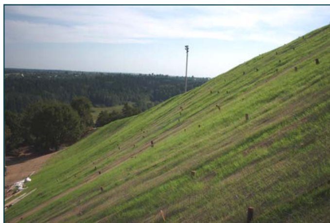
Рис. 5 ... защита эродиремого склона с помощью биоматов
