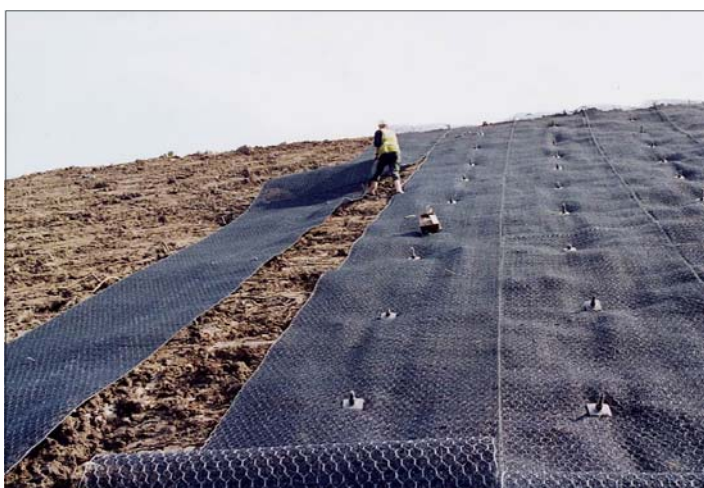
Рис. 5 Перекрывание и анкерирование материала Макмат
