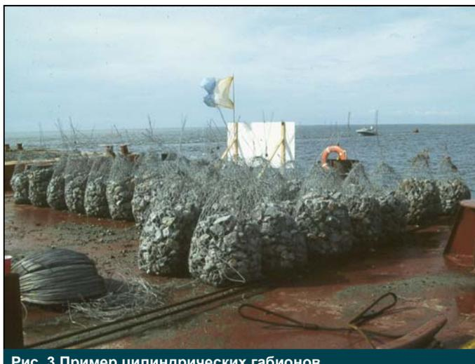
Рис. 3 Пример цилиндрических габионов
