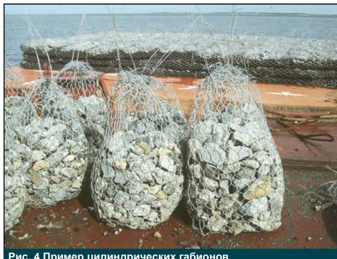
Рис. 4 Пример цилиндрических габионов
