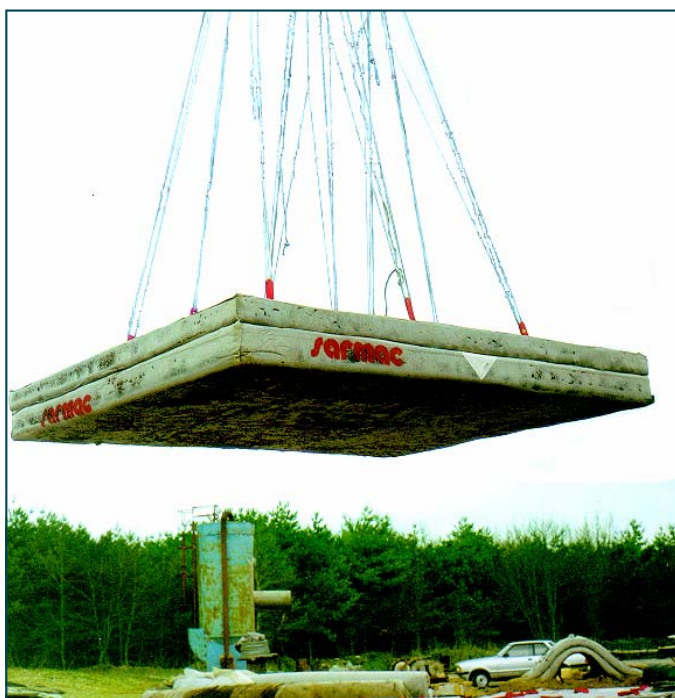
Рис. 4 Укладка мата Сармак
