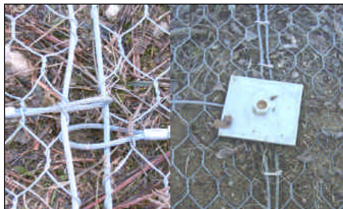
Элементы скрепления и анкеровки
