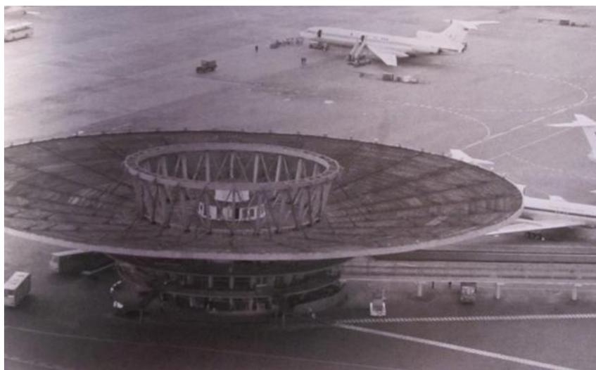
*Рис. 9. Консольно-вантовое покрытие здания галереи для приема пассажиров в аэропорту Шереметьево*
