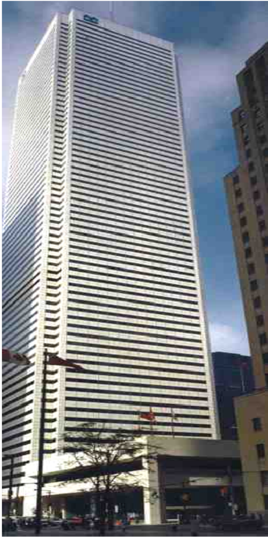
Рис. 1.31 – Высотное здание 72 этажа в г. Торонто, Канада
