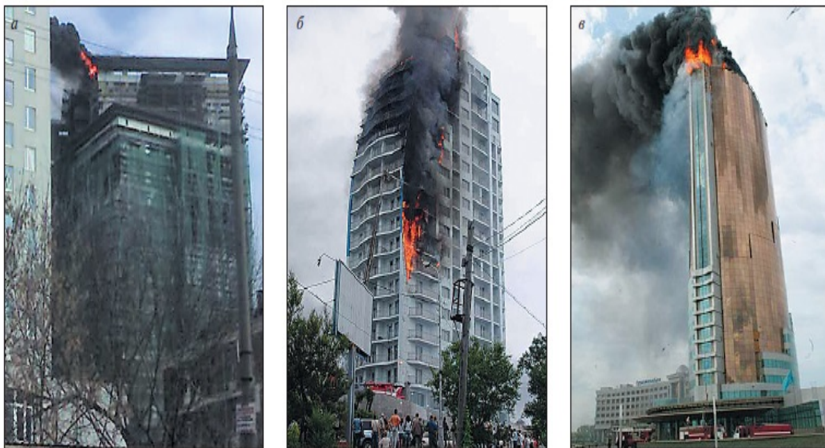
Рис. 1.40 - Пожары в многоэтажных зданиях создают угрозу жизни значительному количеству людей и наносят огромный материальный ущерб: а – пожар в жилом доме на Кутузовском проспекте (Москва); б – пожар в жилом комплексе «Атлантис» (Владивосток); в – пожар в 32этажном административном здании (Астана, Республика Казахстан)
