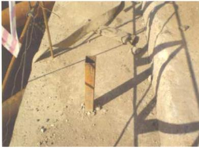
Рис.10.4. Пример выполнения инклинометрической скважины в «стене в грунте» торгово-административного комплекса с подземной автостоянкой
