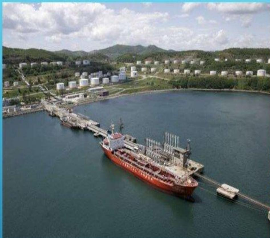
В завершении пути следования нефть поступает на **конечный пункт**. Здесь производится ее прием, учет, перевалка на другие виды транспорта или сдача потребителю. Резервуарный парк КП должен иметь такую же вместимость, что и резервуарный парк ГПС.
