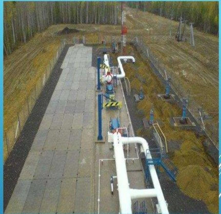
► узлы пуска и приема средств очистки и диагностики (СОД), предназначенные для очистки внутренней поверхности трубопровода в процессе эксплуатации, а также для запуска и приема внутритрубных инспекционных снарядов.
