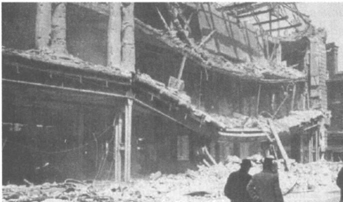
**Рис. 11.6.** Деформации поврежденного каркаса
