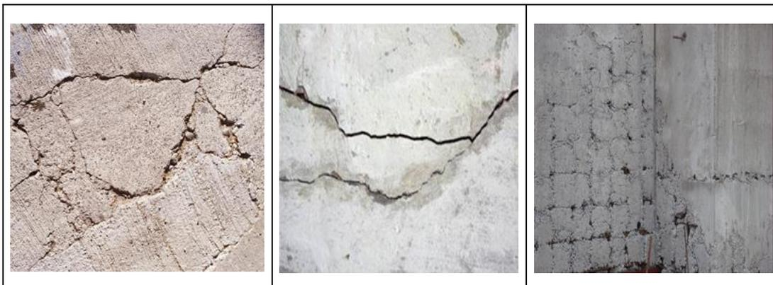
Трещины выявляются путем осмотра открытых поверхностей конструктивных элементов перекрытий и узлов их соединения (поперечных и продольных балок, полков плит).
